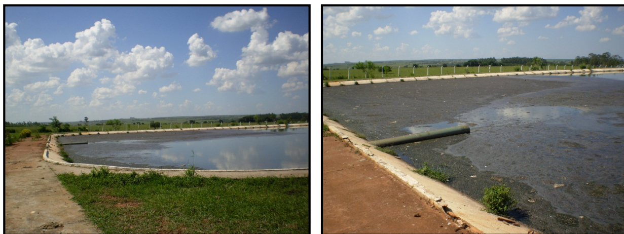
Figura 41: Chegada do esgoto bruto, após o tratamento preliminar, às lagoas de tratamento de Teodoro Sampaio. Fotos: Santi, L.J. (2012).
