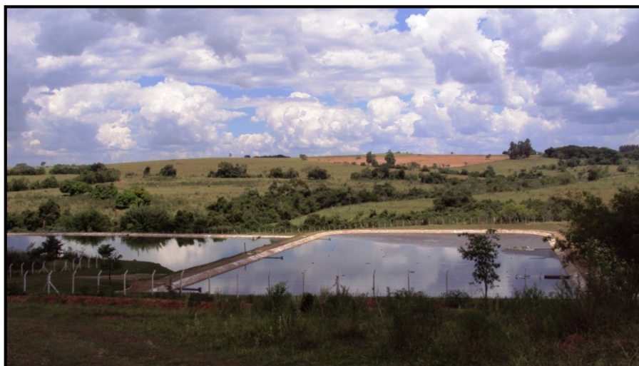
Figura 56: Lagoa anaeróbia e aeróbia de Regente Feijó. Foto: Santi, L.J. (2012).
