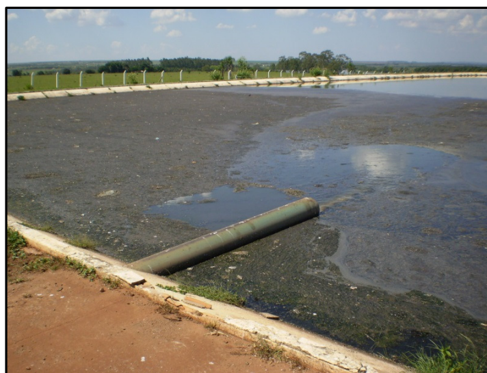
Figura 42: Presença de sólidos flutuantes nas proximidades da tubulação de chegada do afluente. Foto: Santi, L.J. (2012).
