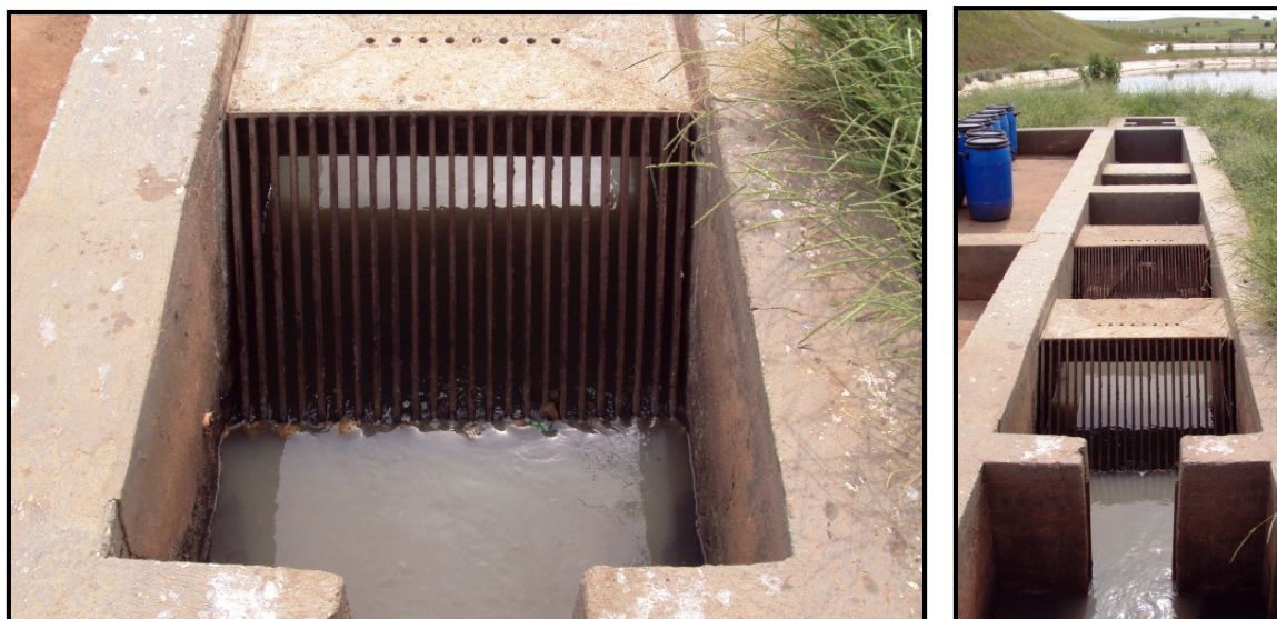
Figura 47: Tratamento preliminar do esgoto que chega à estação de Marabá Paulista. Fotos: Santi, L.J. (2012).
