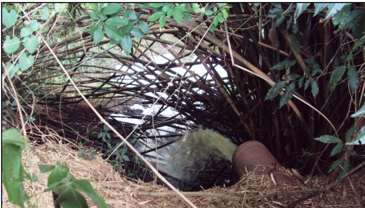
Figura 61: Lançamento do efluente no corpo hídrico receptor. Foto: Santi, L.J. (2012).
