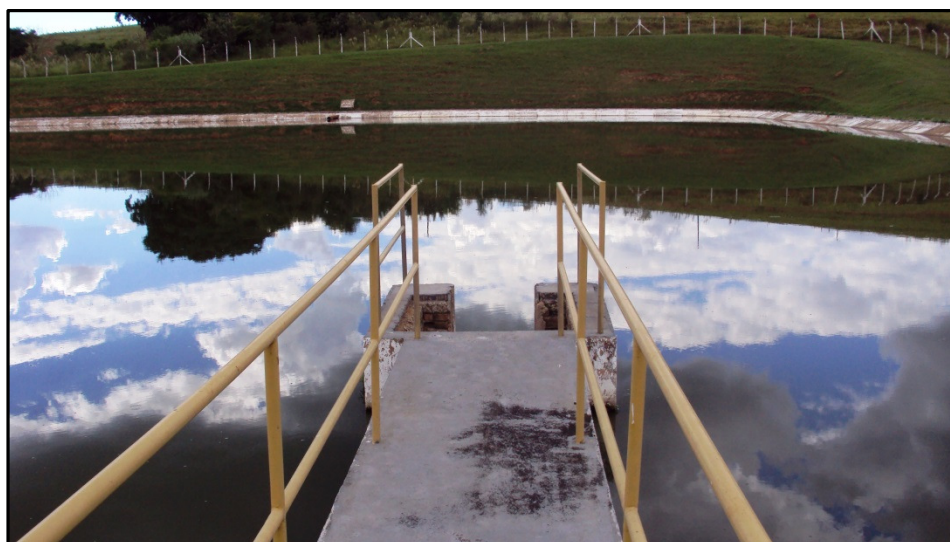
Figura 59: Caixa coletora de efluente localizada no final da passarela. Foto: Santi, L.J. (2012).
