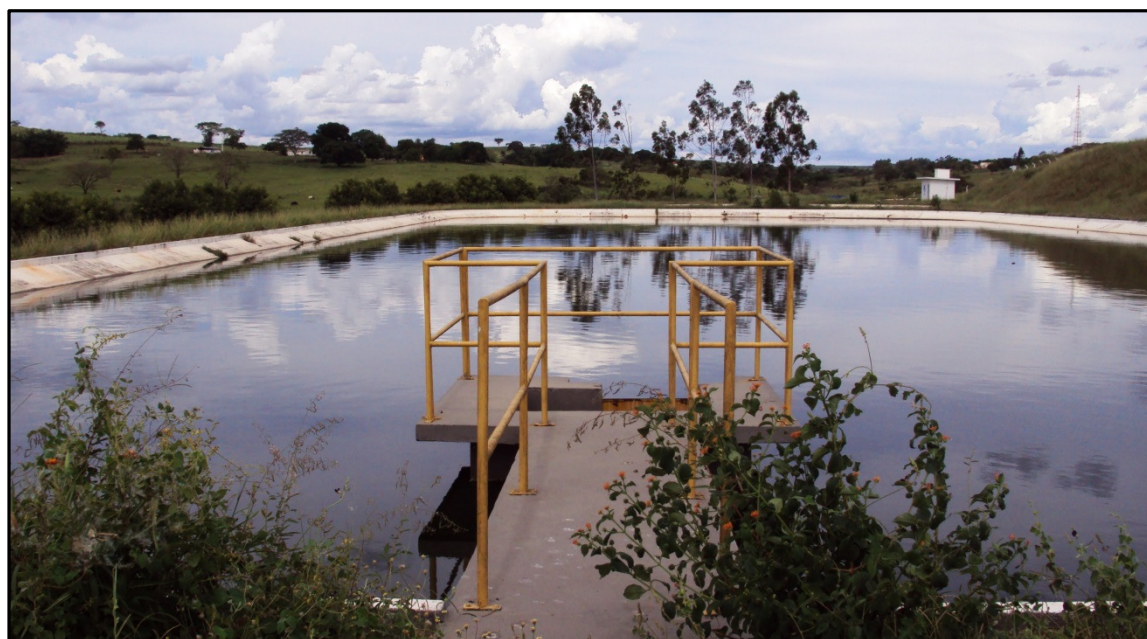
Figura 50: Vista da lagoa aeróbia de Marabá Paulista. Foto: Santi, L.J. (2012).
