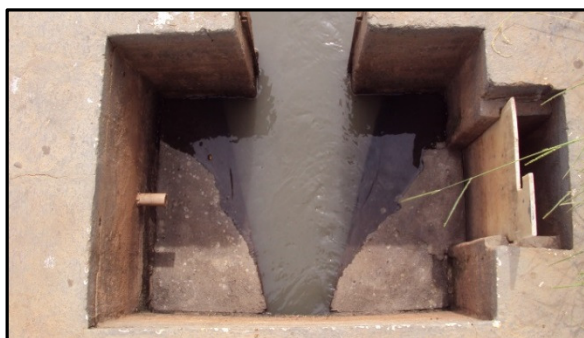
Figura 48 Chegada de afluente à estação de Marabá Paulista. Foto: Santi, L.J. (2012).
