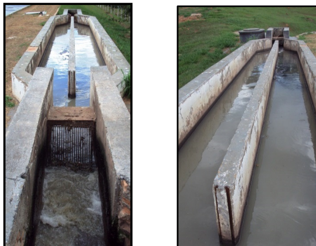
Figura 55: Tratamento preliminar: gradeamento e caixa de areia da chegada do afluente às lagoas de Regente Feijó. Fotos: Santi, L.J. (2012).
