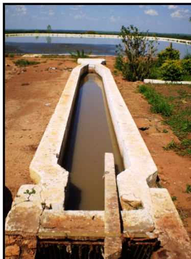
Figura 40: Tratamento Preliminar – Desarenador da ETE de Teodoro Sampaio. Foto: Santi, L.J. (2012).
