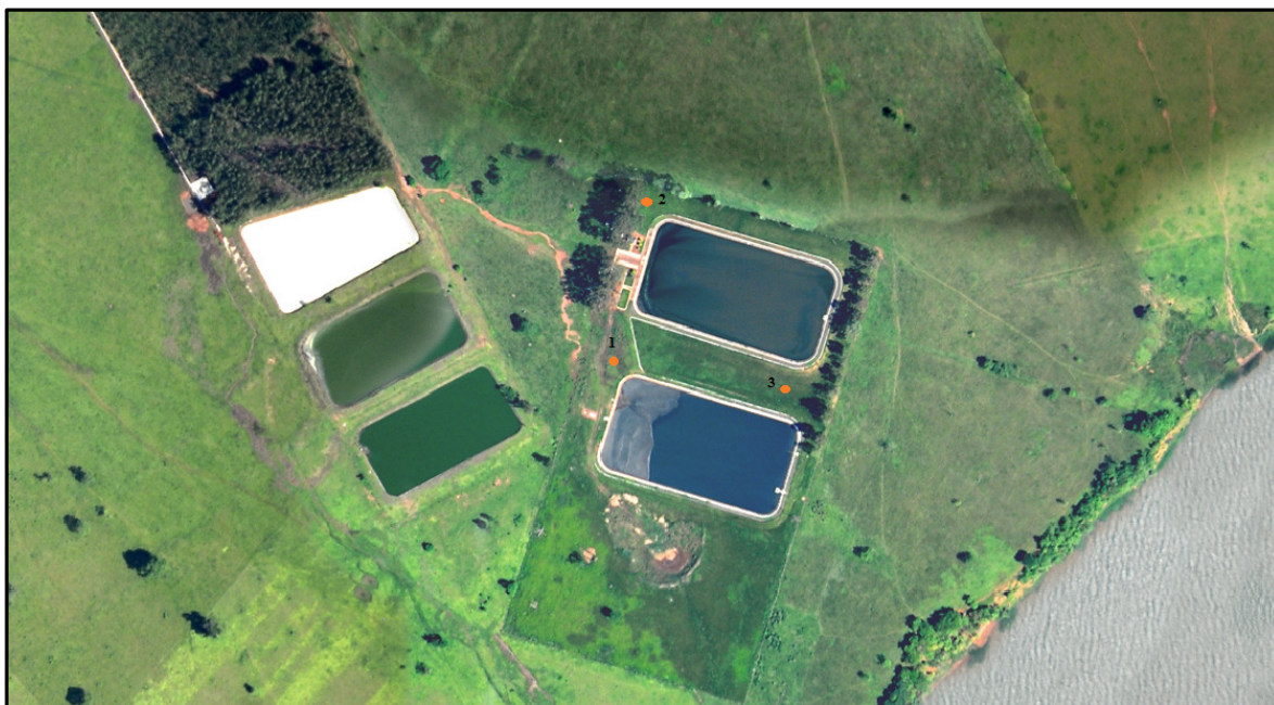
Figura 31: Localização dos pontos que foram realizados os ensaios de permeabilidade. Fonte: Prefeitura Municipal de Teodoro Sampaio.
