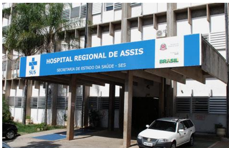
Figura 5 – O Hospital Regional de Assis atualmente
