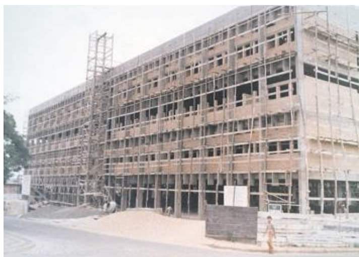
Figura 4 – O Hospital Regional de Assis em fase de construção
