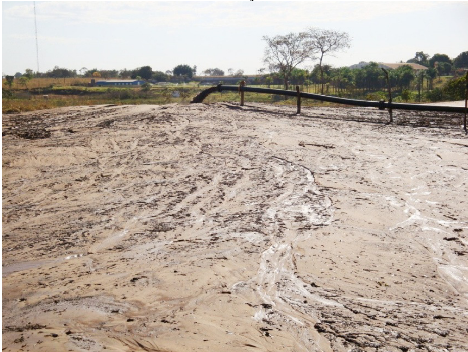
Figura 15 - Sedimentos retirados do canal de adução da PCH Costa Rica
