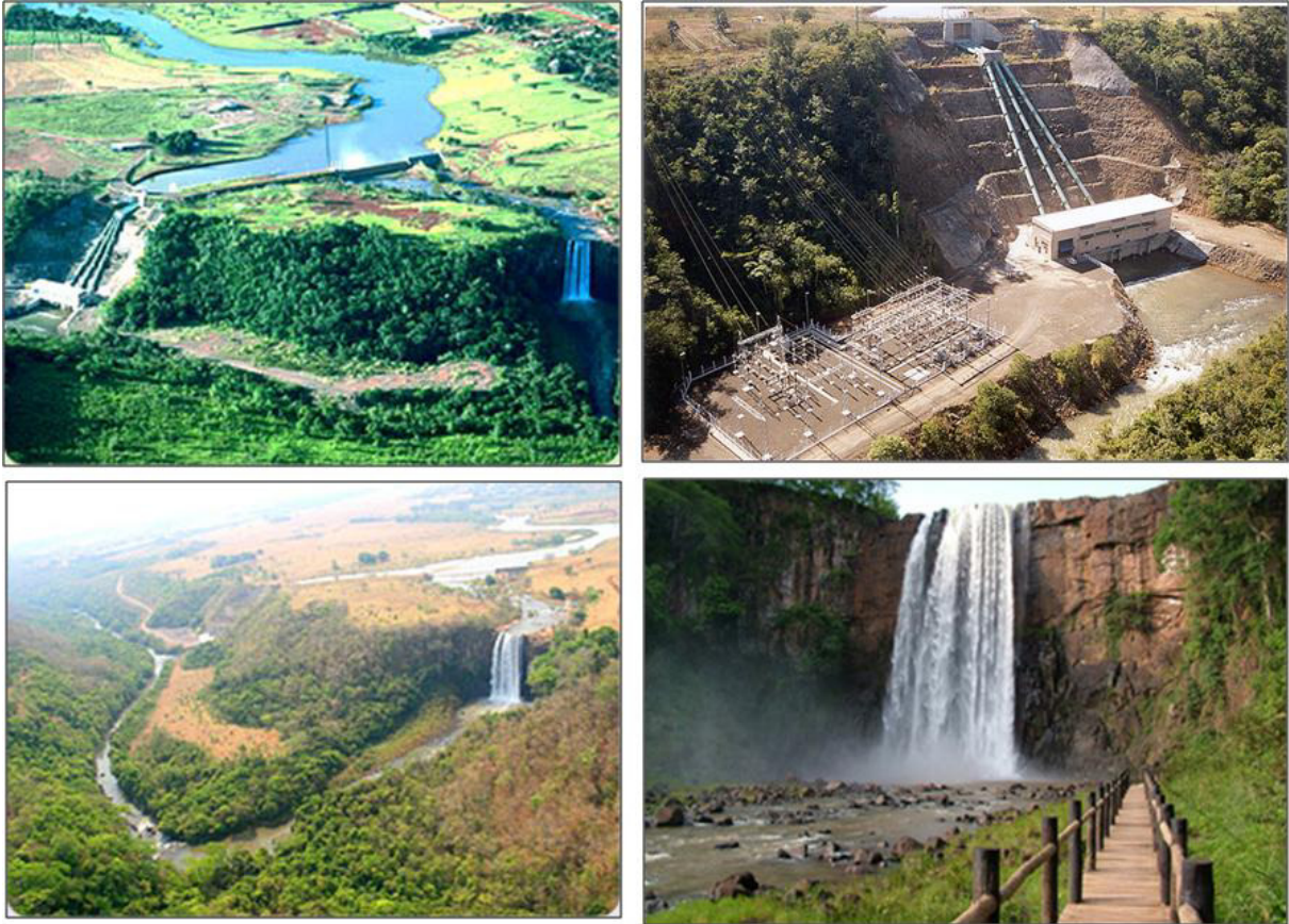
Figura 13 - PCH Costa Rica, em funcionamento desde 1997, utilizando a água do rio Sucuriú próxima ao Salto Majestoso
