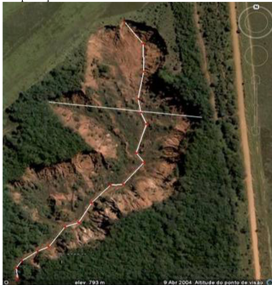
Figura 16 - Principal voçoroca localizada à montante do reservatório da PCH de Costa Rica
