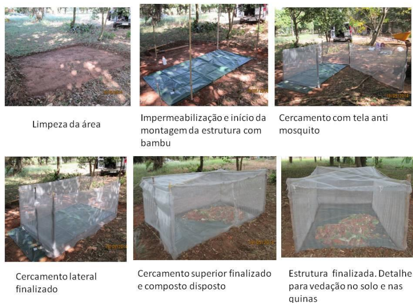
Figura 9. Etapas da montagem do canteiro de compostagem. Fonte: Autor.
