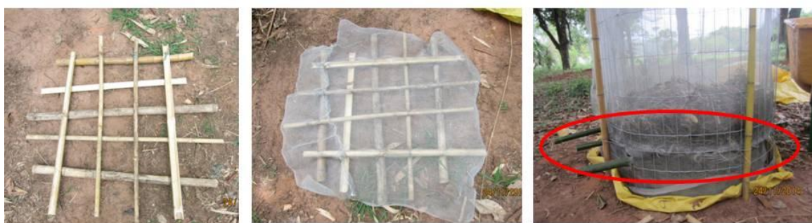
Estrutura de bambu presa com arame
