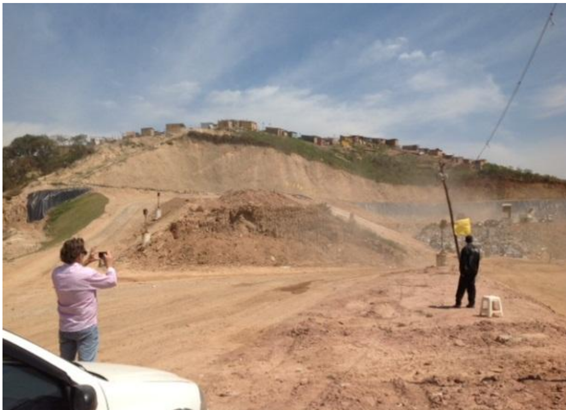
Figura 14 – Vista de área de disposição do aterro sanitário de Osasco, 2014.
