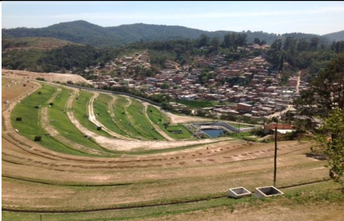
Figura 13– Vista de área encerrada do aterro sanitário de Osasco, 2014.
