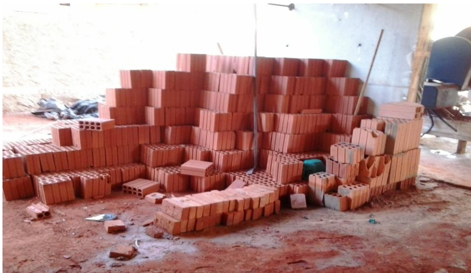
Figura 29: Pátio de estoques de materiais da Construtora
