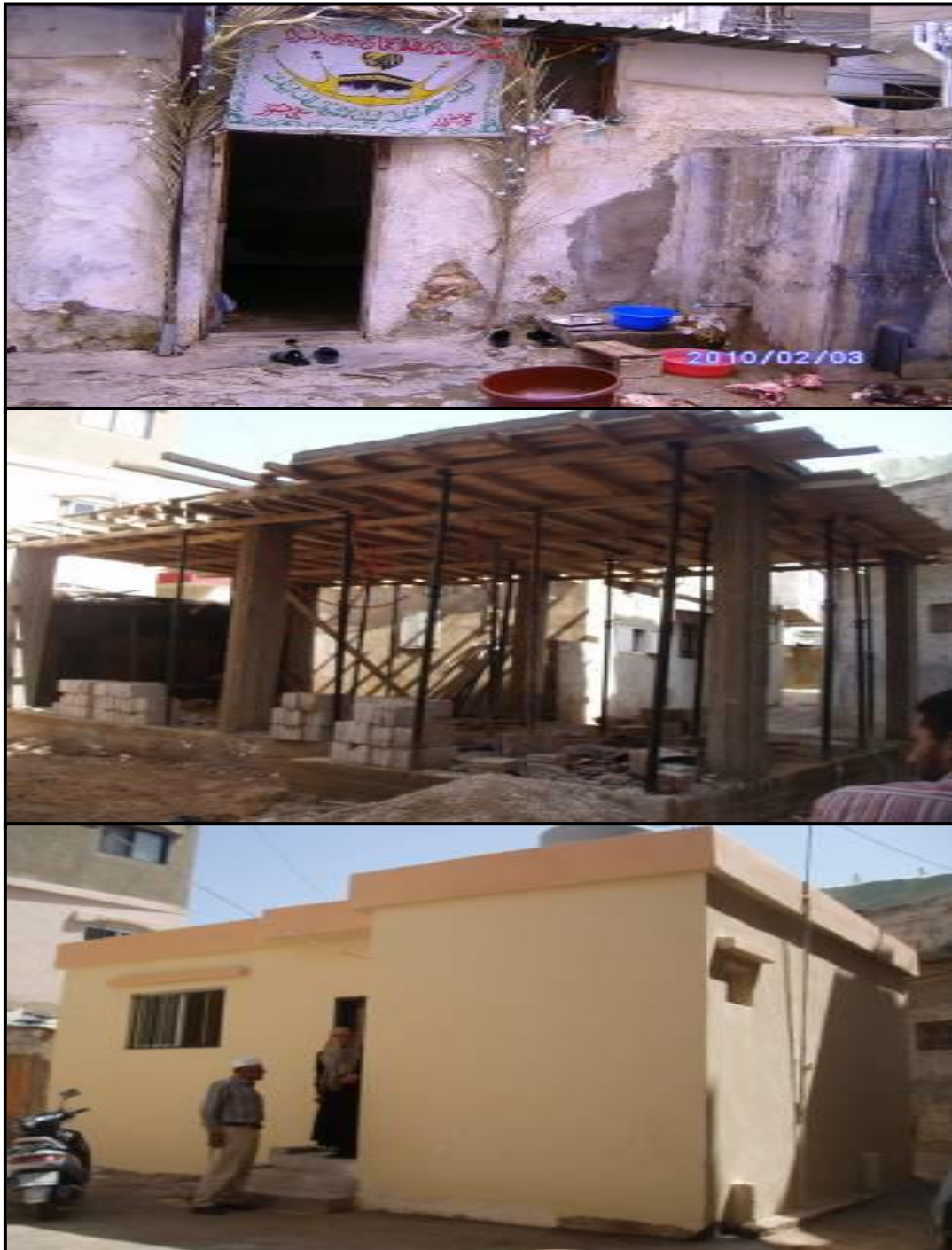
Figura 10: Abrigo antes, durante e após a reabilitação
