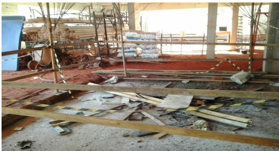
Figura 27: Estoques de Tubulações em PVC na obra da Construtora A
