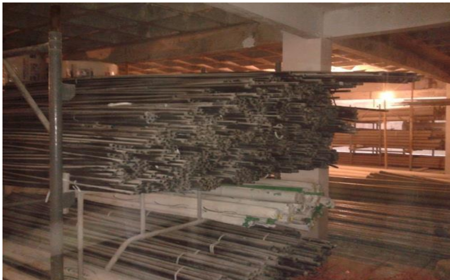
Figura 26: Estoques de Tubulações em PVC na obra da C. Rolim
