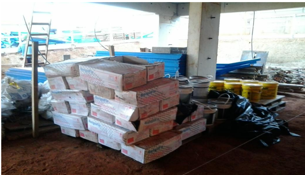
Figura 23: Almoxarifado da Construtora A
