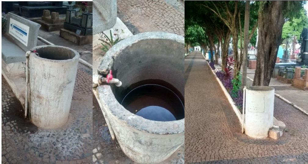
Foto 6.13: Torneiras ao longo da avenida principal.
