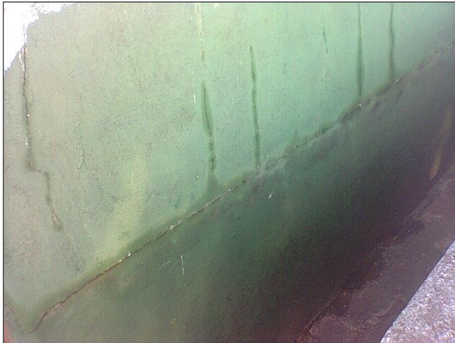
Foto 3.2: Extravasamento de necrochorume no túmulo no Cemitério Municipal de Rio Claro, SP. Fonte: acervo pessoal.
