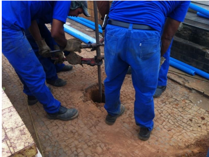
Foto 5.7: Furo de sondagem no interior do cemitério.
