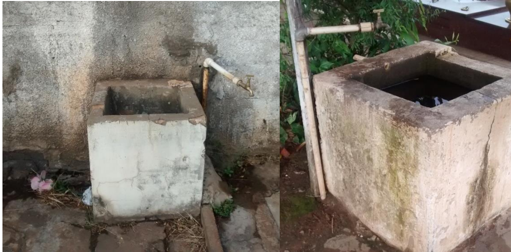
Foto 6.18: Torneiras localizadas ao longo dos muros limítrofes do cemitério Foto 6.19: Idem
