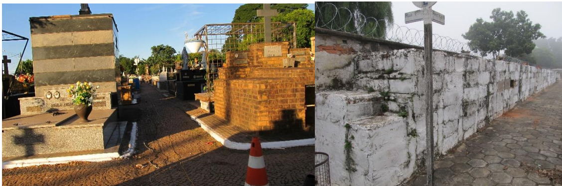
Foto 6.23: Estruturas diversas, artefatos metálicos, decorativos dentre outros.
