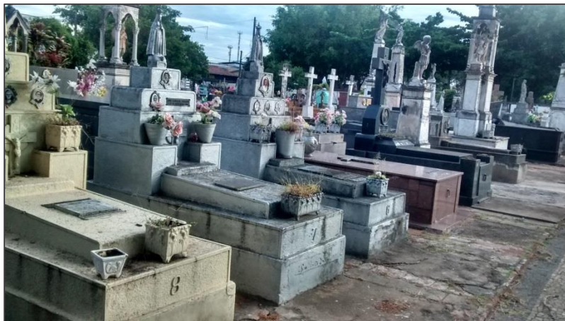
Foto 6.3: Túmulos do início da construção do cemitério.
