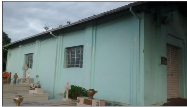
Foto 6.8: visão lateral da capela.
