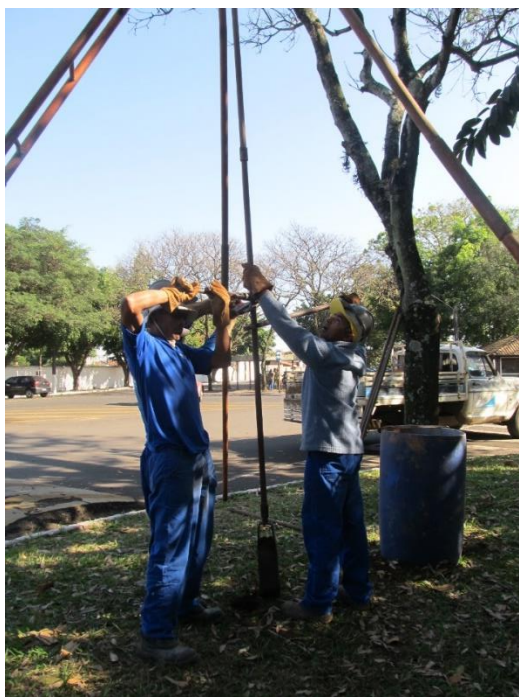
Foto 5.6: Furo de sondagem sendo executado na área externa ao Cemitério Municipal.
