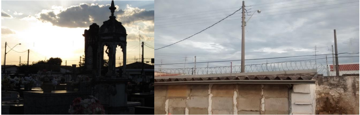
Fotos 6.16: muro com cerca elétrica e postes de iluminação do lado de fora, paralelos ao muro do cemitério.
