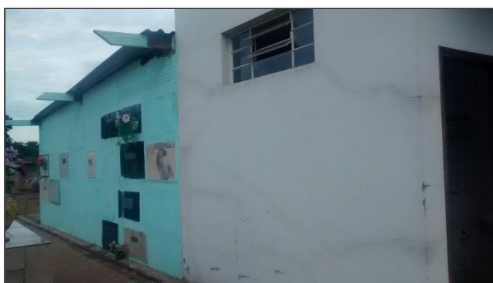
Foto 6.27: Banheiro (branco) e cemitério de indigentes (verde), próximos ao portão lateral.
