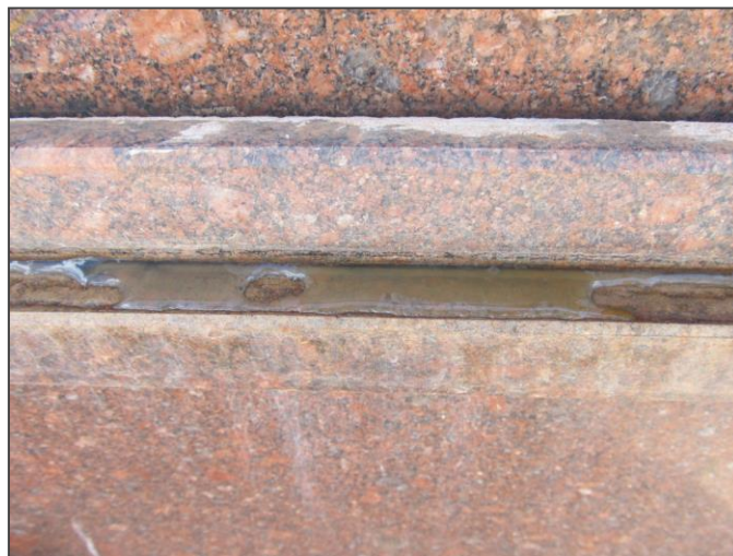
Foto 3.3: Extravasamento de necrochorume no túmulo no Cemitério Municipal de Rio Claro, SP. Fonte: acervo pessoal.
