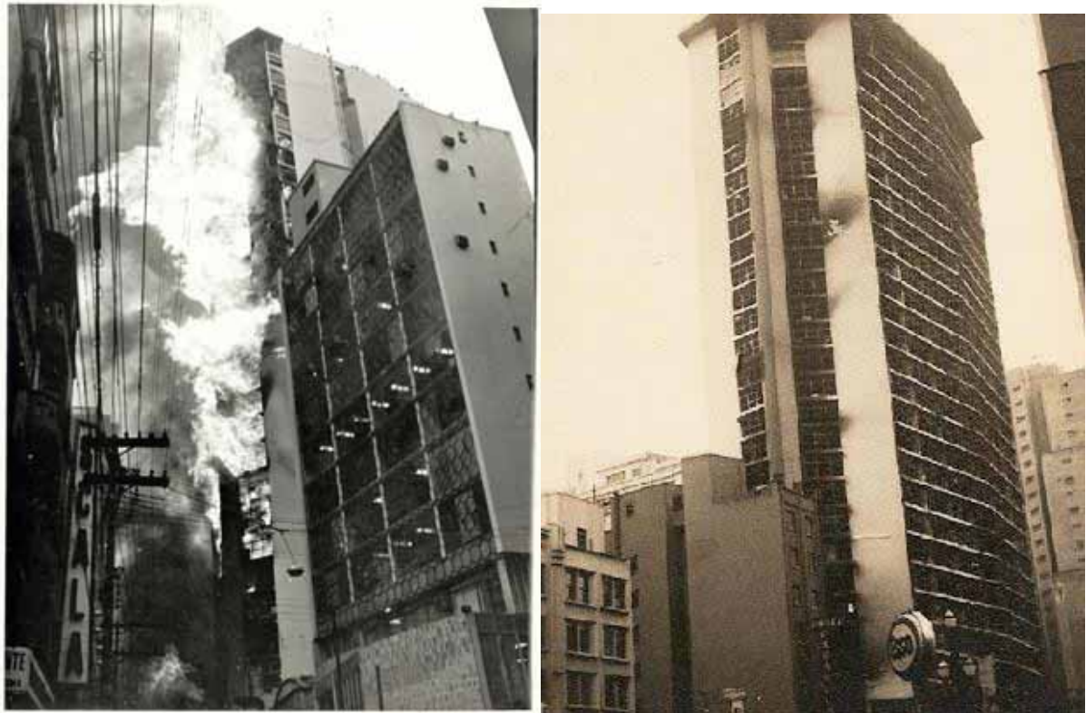
Figura 1 – a. Edifício Andraus atingido pelo incêndio b. Edifício Andraus destruído após o incêndio
