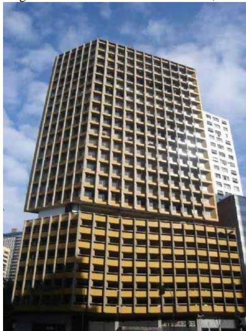
Figura 4 – Edifício Joelma restaurado, 2014
