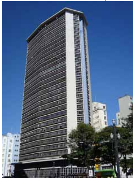
Figura 2 – Edifício Andraus restaurado, em 2010
