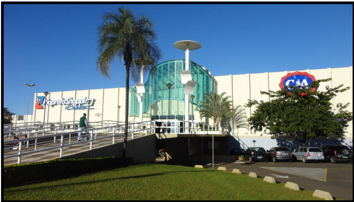
Figura 3: Rio Preto Shopping Center. São José do Rio Preto. 2014
