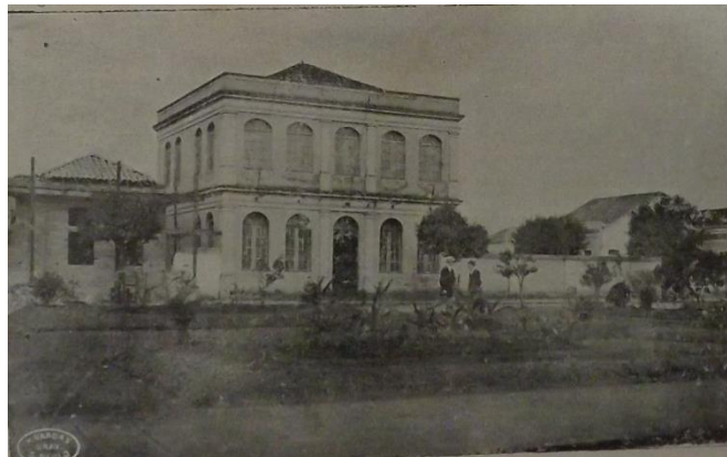
Imagem 61 O edifício em que se acha instalada a nossa edilidade. Almanach Ilustrado de 1913.
