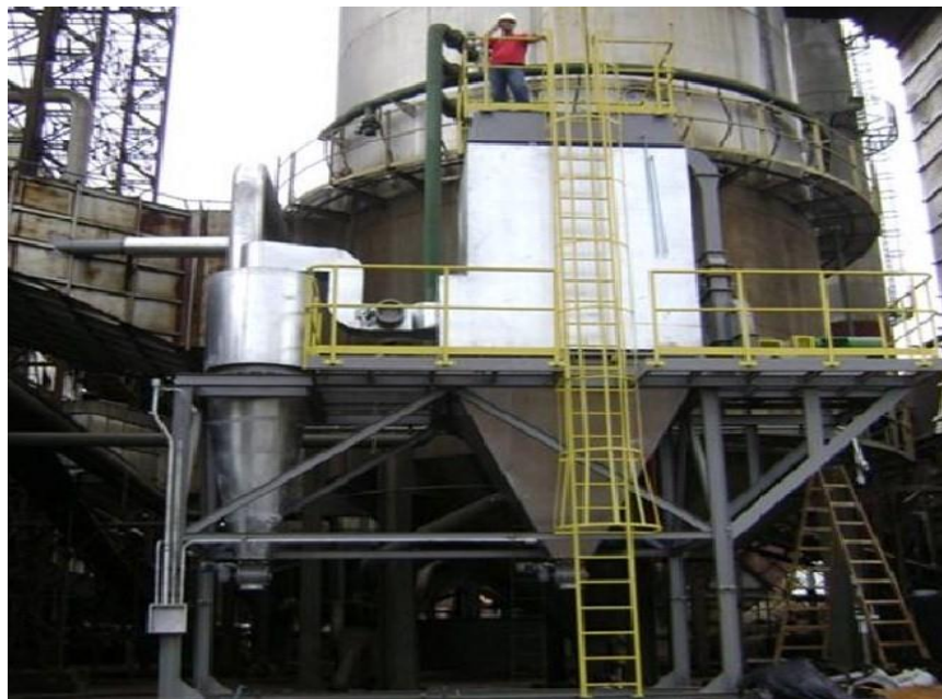
Figura 1. Instalação piloto típica de tratamento de gases
