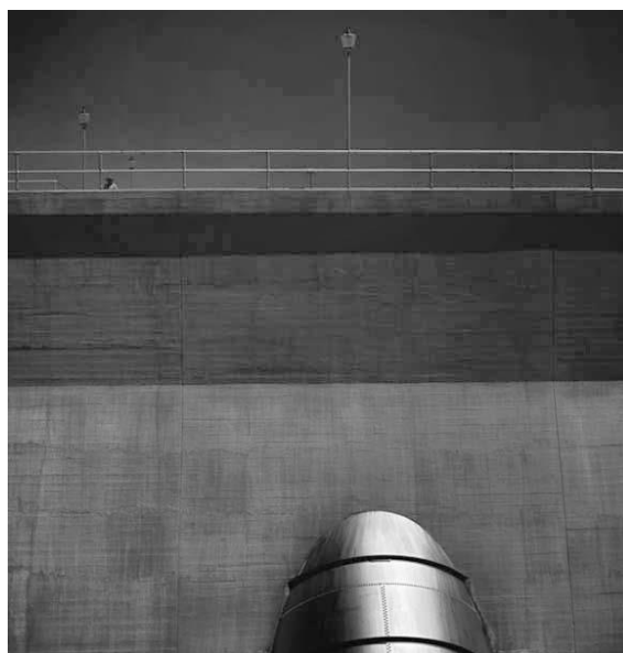
Figura 3: Barragem de Usina, 1951, Thomas Farkas. Fonte: COSTA & SILVA, 2004
