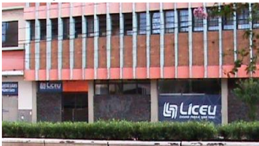
Figura 2 - Fachada da escola Liceu Noroeste
