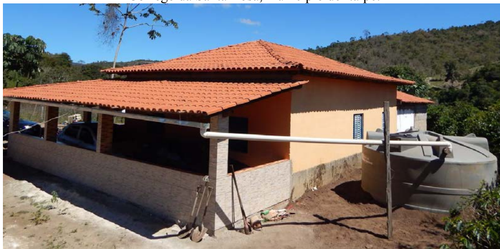
Figura 18 - Cisterna de polietileno instalada pelo Programa Água para Todos, Córrego da Santa Rosa, município de Itaipé.
