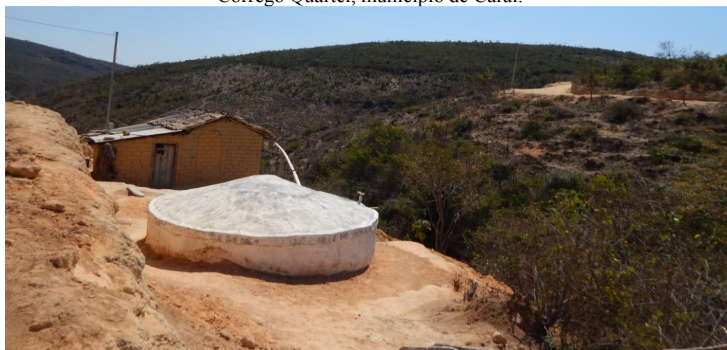
Figura 19 - Cisterna de placa instalada pelo Programa Um Milhão de Cisternas, Córrego Quartel, município de Carai.
