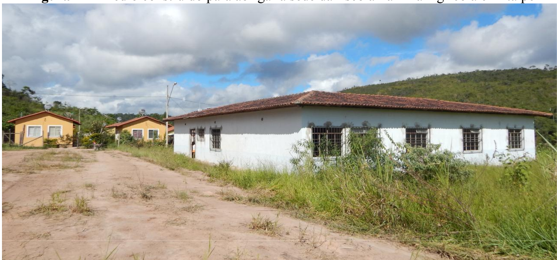
Figura 12 - Prédio construído para abrigar a sede da Escola Família Agrícola em Itaipé
