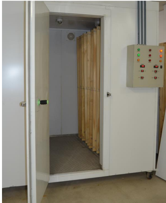
Figura 50 - Interior da câmara de climatização
