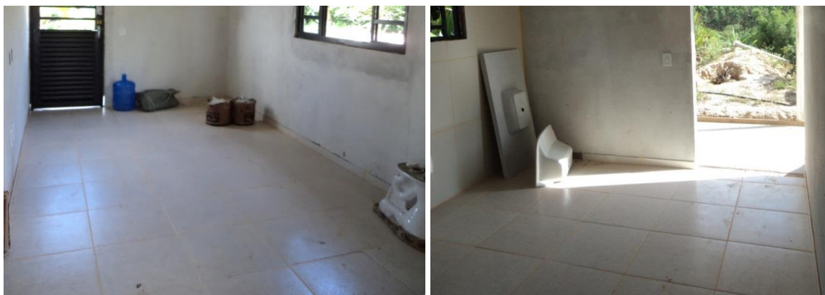
Figura 15 – Revestimento do piso com cerâmica PEI 5.
