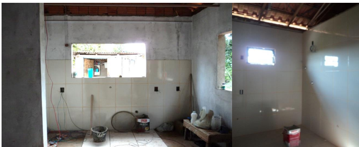
Figura 17 - Parede revestida de azulejo na altura de 1,50 metros na cozinha e até o teto no banheiro.
