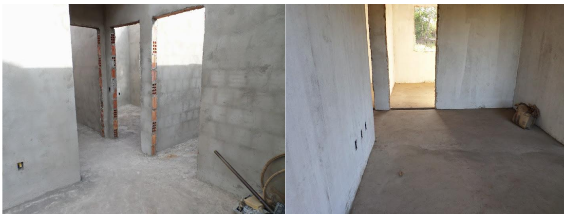
Figura 14 – Regularização de piso para assentamento de cerâmica.
