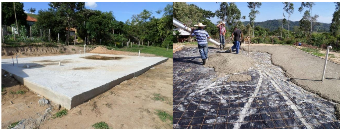
Figura 13 – Fundação do tipo radier . Solução construtiva adotada nas unidades habitacionais executadas pela Fetaesp.
