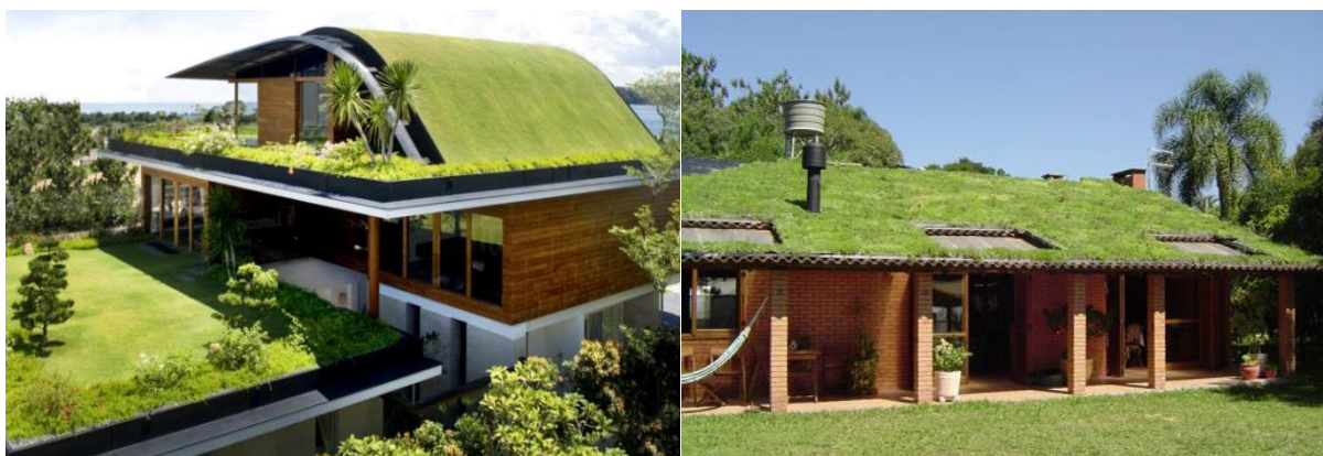
Figura 11 – Telhado verde. Solução utilizada para melhorar as condições de conforto térmico e ambiental.
