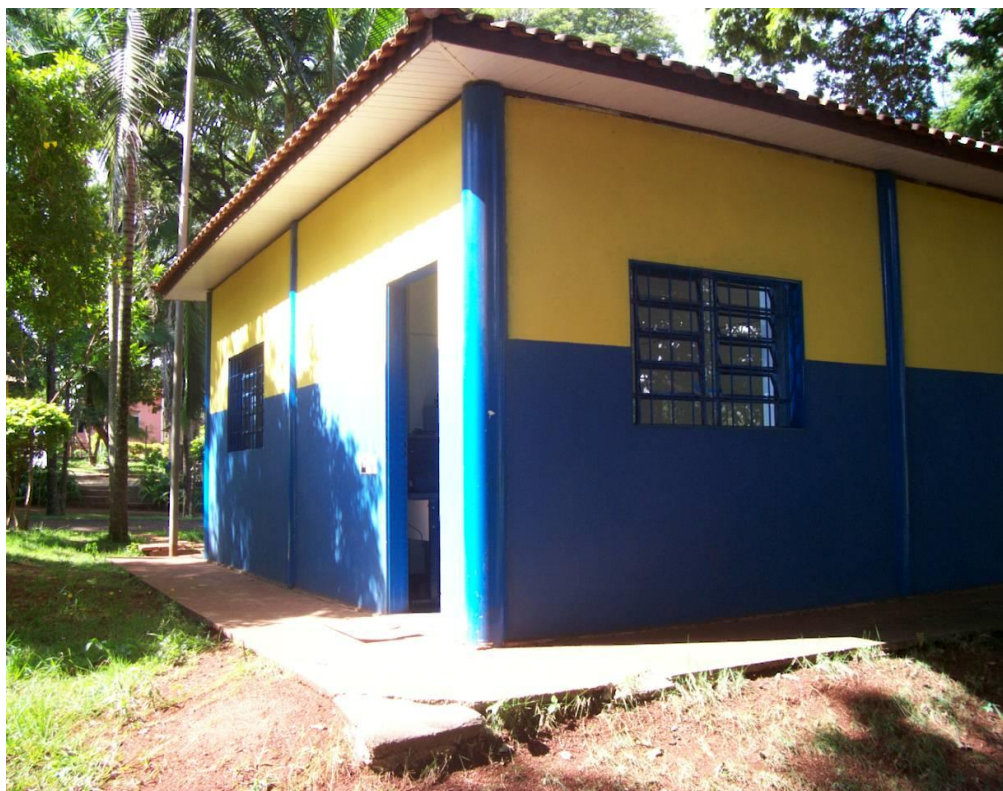
Foto 2 - Porta de acesso à SRM
