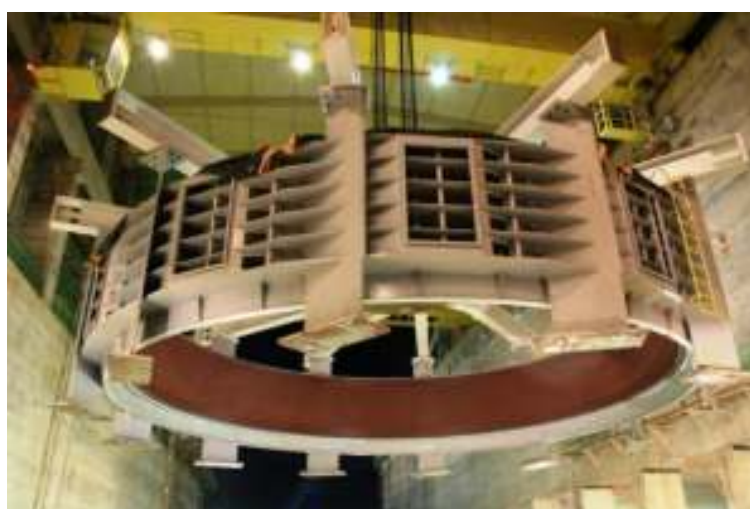
Figura 13 – Estator do gerador da unidade geradora 01 da UHE Estreito.
