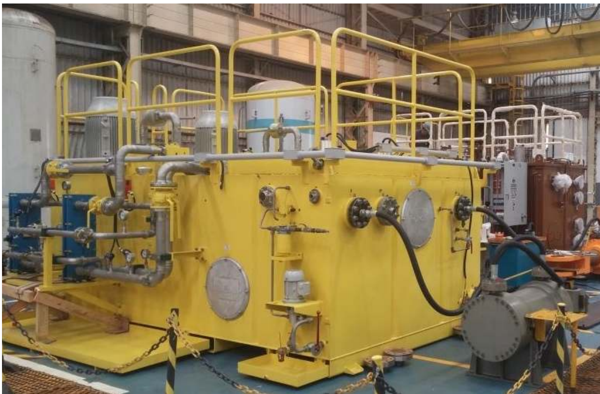
Figura 11 – UHRV da unidade geradora 01 da UHE Cachoeira Caldeirão.
