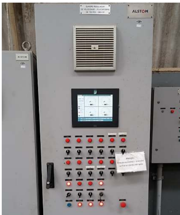
Figura 9 – Painel elétrico de comando de um sistema de regulação de velocidade.
