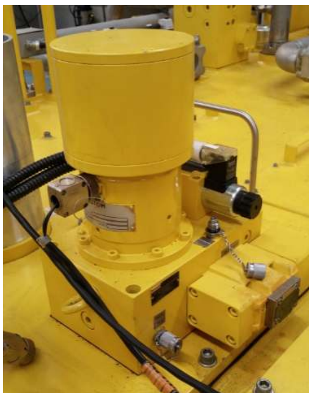
Figura 10 – Válvula proporcional da UHRV 01 da UHE Cachoeira Caldeirão.
