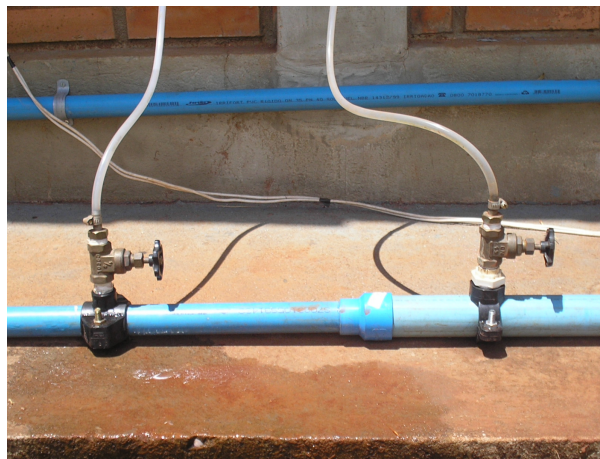
Figura 6 - Posicionamento dos colares de tomada de pressão
