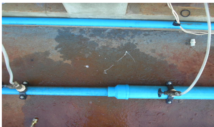
Figura 2 - Redução concêntrica de 75x50mm com os colares de tomada de pressão
