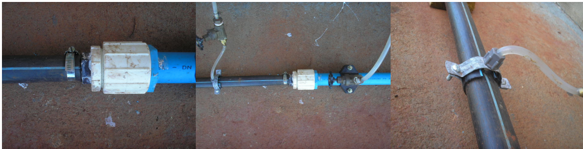
Figura 04 - Redução concêntrica de 35x1''(adaptada) e colares de tomada de pressão
