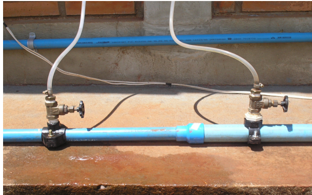
Figura 3 - Redução concêntrica de 50x35mm com os colares de tomada de pressão
