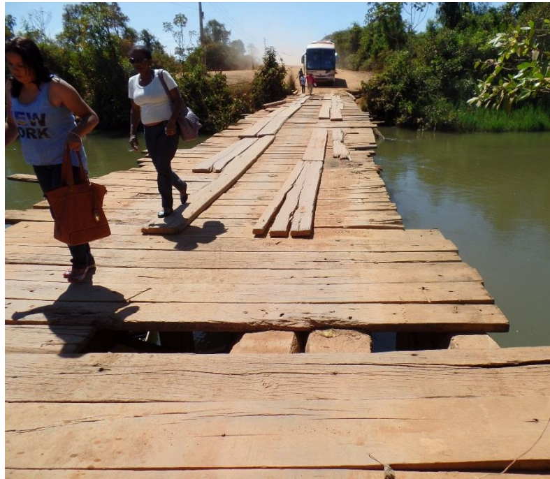
Figura 54: Pessoas caminhando sobre a ponte que tem risco de desabar.
