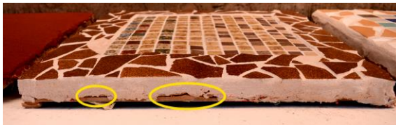
Figura 141 – Teste 6: Trincas destacadas em amarelo.
