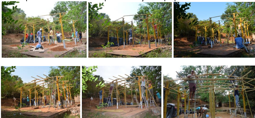
Figura 4. Etapas do mutirão realizado para instalação da pequena estrutura feita em bambu.
