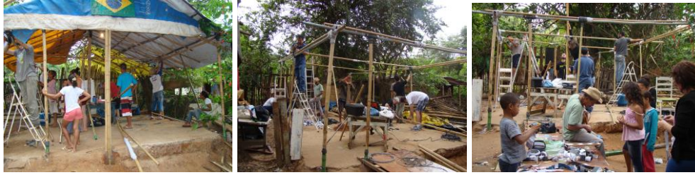
Figura 3. Etapas da desmontagem da estrutura para a reforma.
