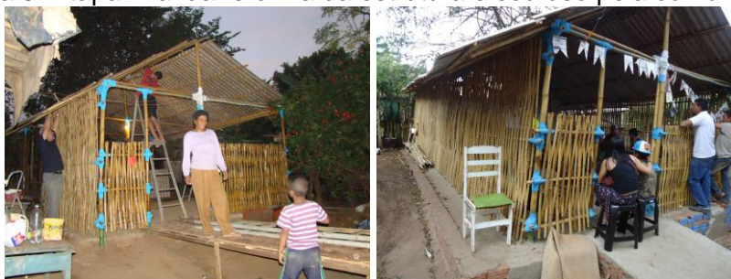
Figura 5. Etapa final da reforma da estrutura e seu uso pela comunidade.
