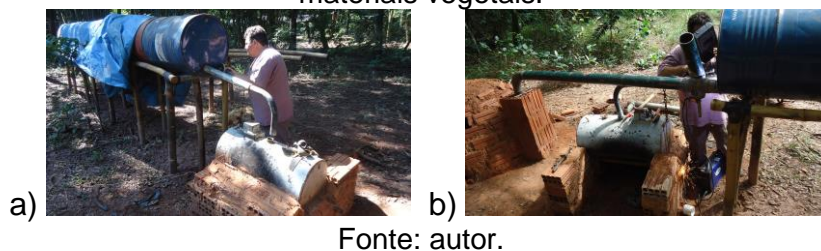
Figura 7. a) Confeção da chaminé do forno de vapor; b) Confeção da chaminé do forno de fumaça, visando também futuras extrações do Pirolenhoso gerado com a queima dos materiais vegetais.
