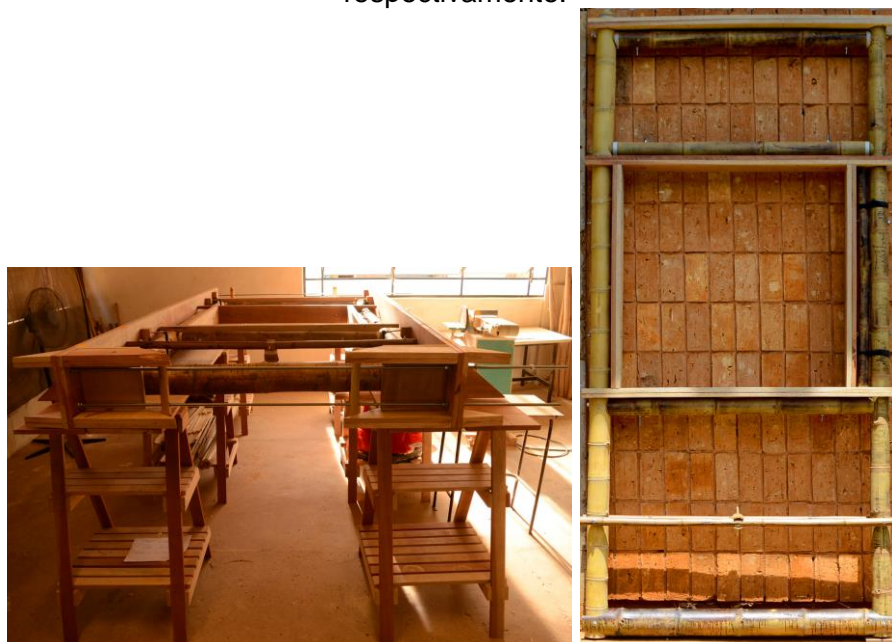
Figura 117 – Etapa da montagem do painel modular janela e seu protótipo finalizado, respectivamente.
