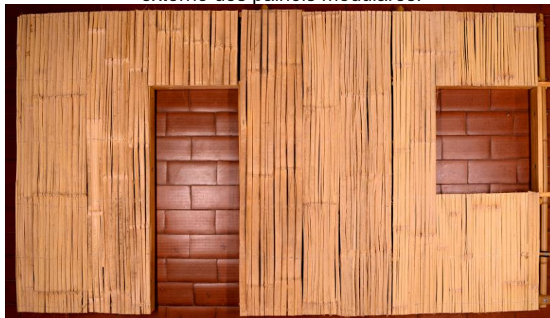
Figura 94. Modelos em escala 1:2 - simulação de fechamento com uso das esteiras, lado externo dos painéis modulares.
