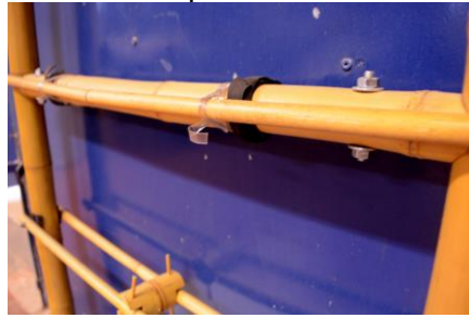
Figura 84. Tiras de câmaras de ar associadas a tiras de PET, removidas no projeto final dos painéis.
