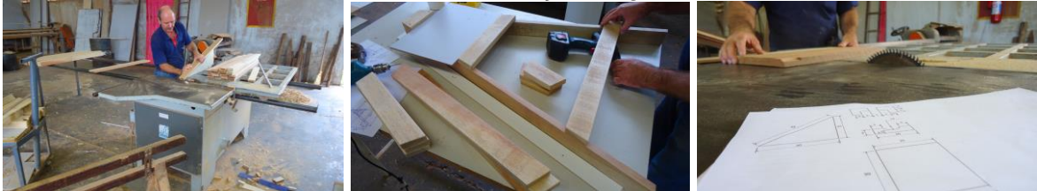
Figura 105. Construção do gabarito.
