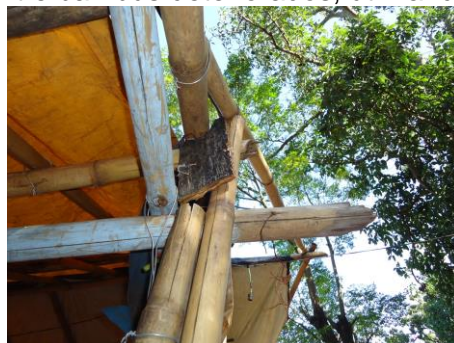
Figura 2. Uniões entre bambus deteriorados, utilizando arame e madeira.
