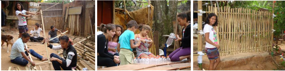
Figura 4. Etapas da produção dos novos componentes construtivos da estrutura.
