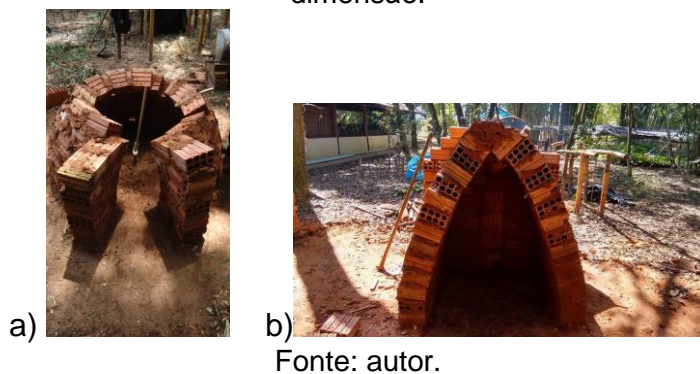
Figura 2. a) Etapa da construção do forno similar ao de carvão vegetal; b) Reconstrução do forno, uma vez que o projeto anterior se demonstrou inviável para uso, devido a sua dimensão.
