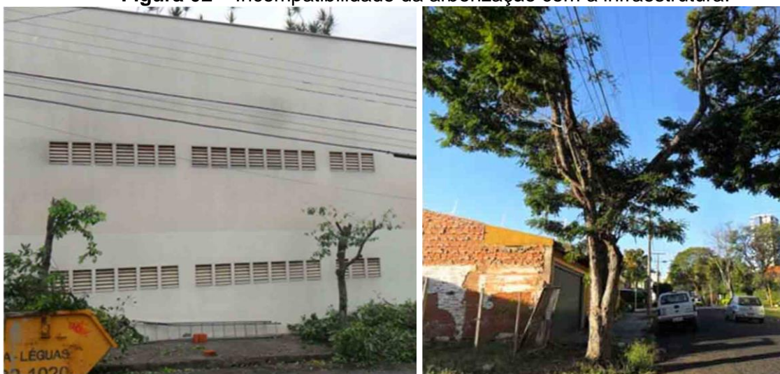
Figura 02 – Incompatibilidade da arborização com a infraestrutura.
