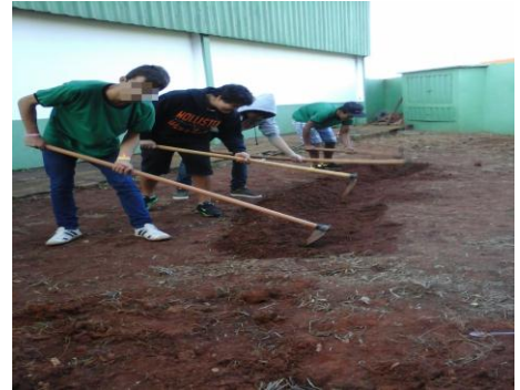
Figura 6: Construindo os canteiros
