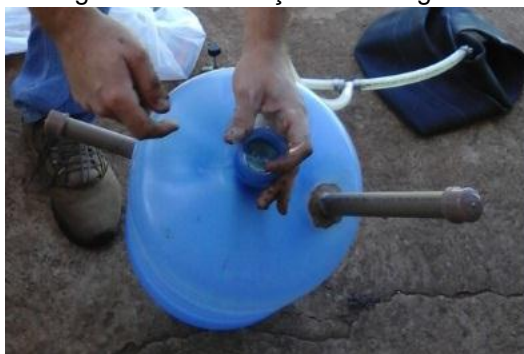
Figura 10: Construção do biodigestor
