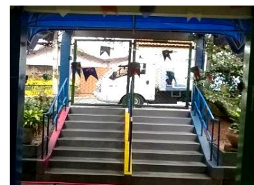
Figura 138 – Escada que prejudica a acessibilidade dos alunos
