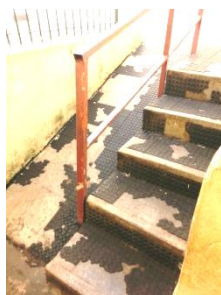
Figura 35 – Inadequação da rampa e da escada de acesso ao Edifício II
