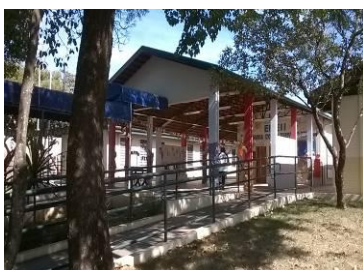
Figura 89 – Rampa de acesso à escola acessível
