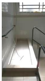
Figura 75 – Área de banho elevada no sanitário dos alunos
