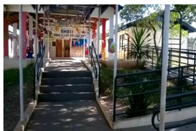
Figura 70 – Desnível na entrada principal para acesso as salas de aula
