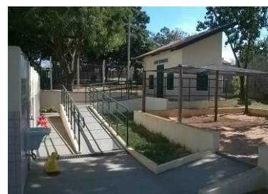
Figura 82 – Localização do bebedouro sem uma área de circulação
