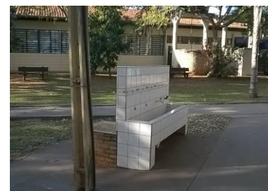
Figura 106 – Localização do bebedouro podendo ser um obstáculo para o deficiente visual
