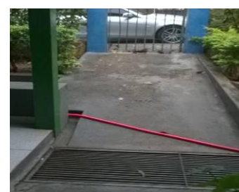
Figura 121 – Rampa e grelha posicionados na entrada da escola
