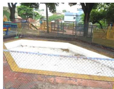
Figura 37 – Piscina com ausência de equipamentos de acessibilidade
