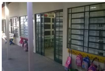
Figura 114 – Desnível para acesso às salas de aula
