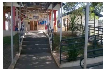
Figura 91 – Escada acesso a escola para alunos
