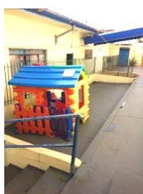
Figura 27 – Desníveis e escadas na circulação externa entre Edifícios I e II
