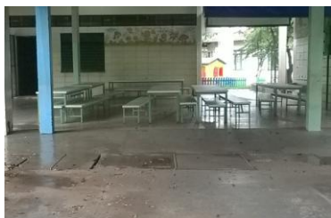
Figura 113 – Tipo de piso no pátio coberto
