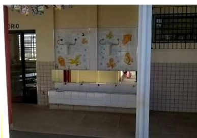
Figura 81 – Bebedouro não acessível
