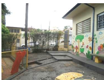
Figura 26 – Existência de degrau na circulação externa próximo ao Edifício
