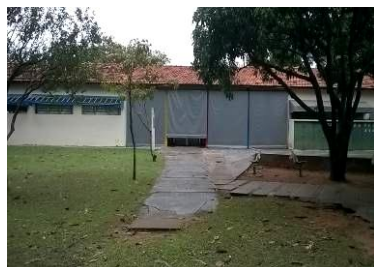
Figura 136 – Rampa não acessível para acesso ao parque infantil
