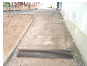
Figura 54 – Posicionamento e dimensionamento da grelha
