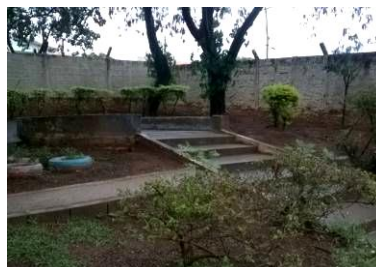
Figura 137 – Escada que prejudica a acessibilidade dos alunos
