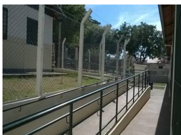
Figura 90 – Rampa lateral acessível
