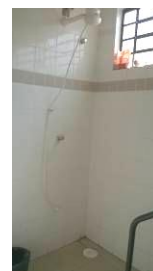
Figura 76 – Chuveiro sem acento no sanitário dos alunos
