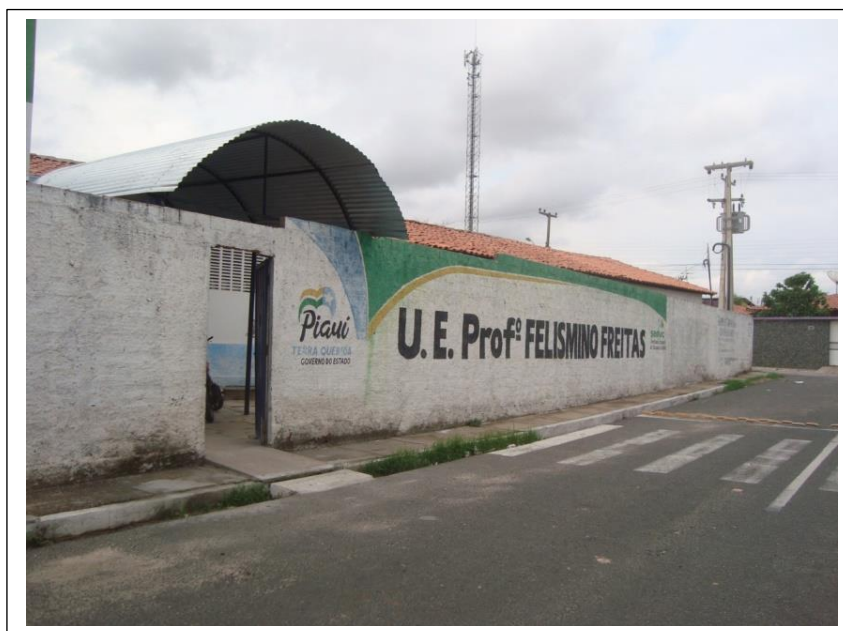
Figura 23 – Fachada da Unidade Escolar Felismino Freitas, no Bairro Mocambinho
