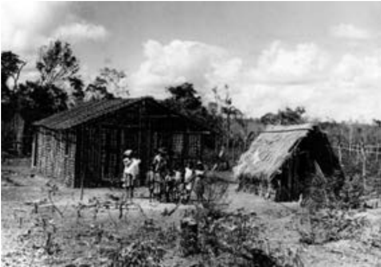
Figura 71 – Casa de camponeses nordestinos entrevistados em pesquisa da USIA e USAID, sobre o perfil dos trabalhadores rurais do Nordeste brasileiro, em 1963.
