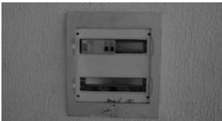
Figura 48 – Equipamento interno deprecitado na área de lazer no Condomínio Terra Nova, em São Carlos
