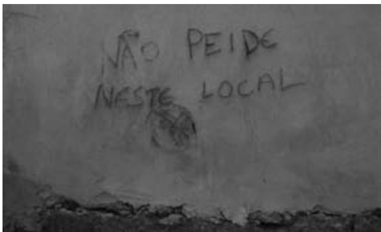
Figura 50 – Muro interno pichado no Condomínio Tecumseh Village, em São Carlos
