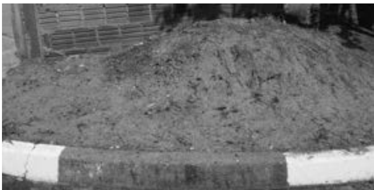
Figura 42 – Calçada ocupada por material de construção no Condomínio Esmeralda, Presidente Prudente
