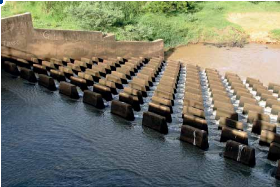
Estação de coleta de água do Rio Santo Anastácio, que abastece 30% da cidade
