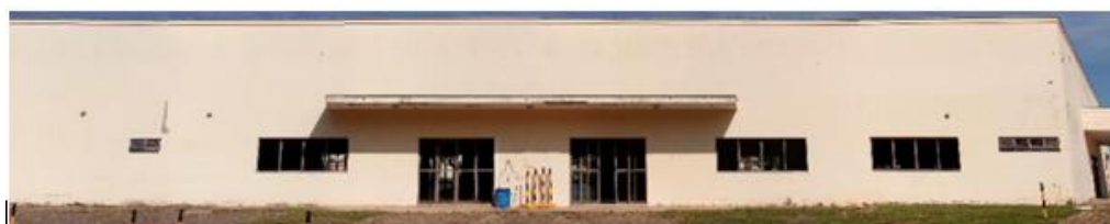
Figura 37: Fachada principal da edificação levantada nos testes de varredura a LASER.
