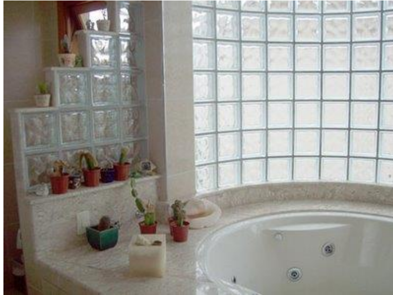
Figura 73 - Tijolos de vidro utilizados no banheiro
