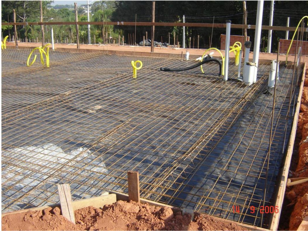
Figura 27 - Fundação do tipo Radier
