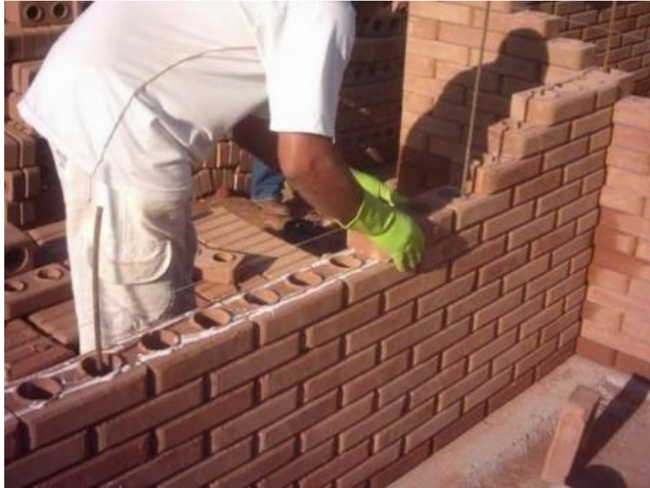
Figura 57 - Acabamento de uma parede de tijolos ecológicos
