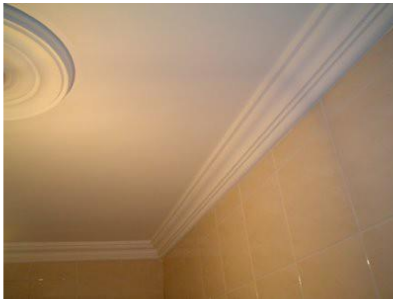
Figura 40 - Detalhe para teto com forro e molduras de gesso
