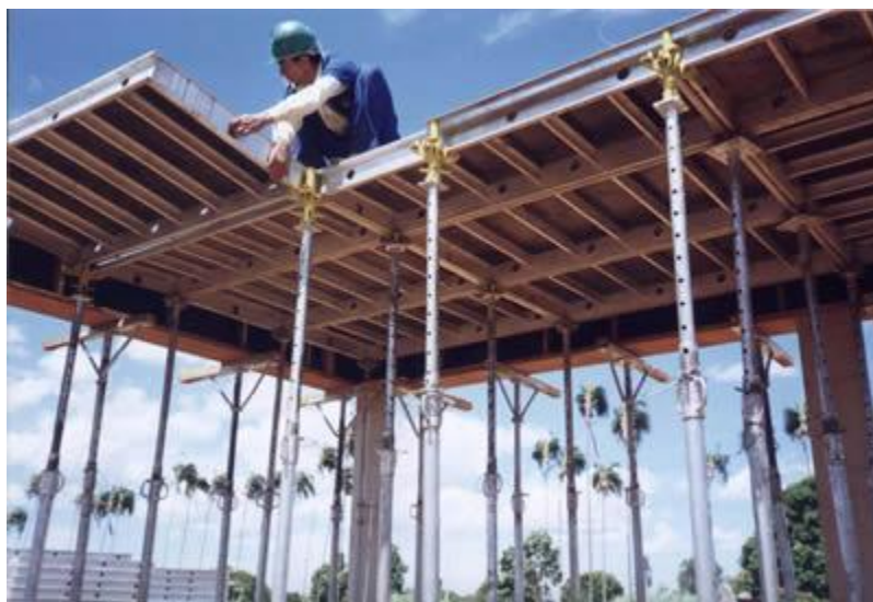
Figura 54 - Formas metálicas
