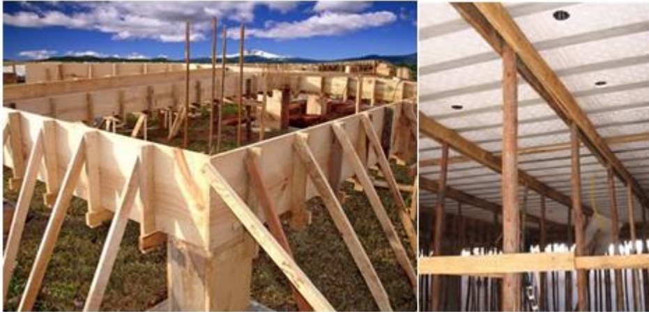
Figura 28 - Formas e escoras de madeira
