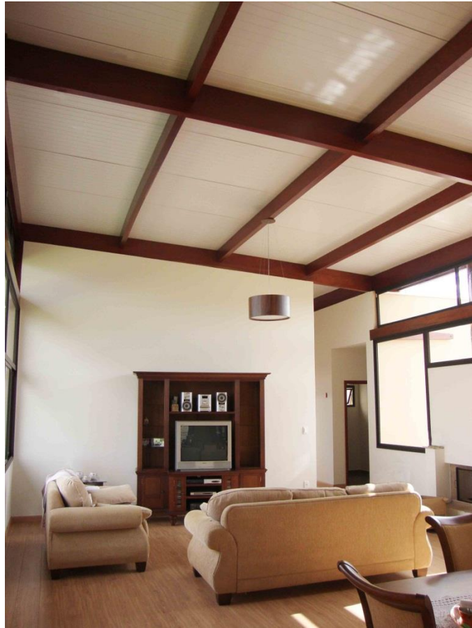
Figura 66 - Detalhe do acabamento interno proporcionado pelo telhado TermoRoof, que dispensa o uso de forros de gesso
