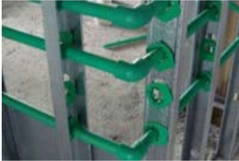
Figura 62 - Tubulações hidráulicas de PPR (Polipropileno copolímero Random)
