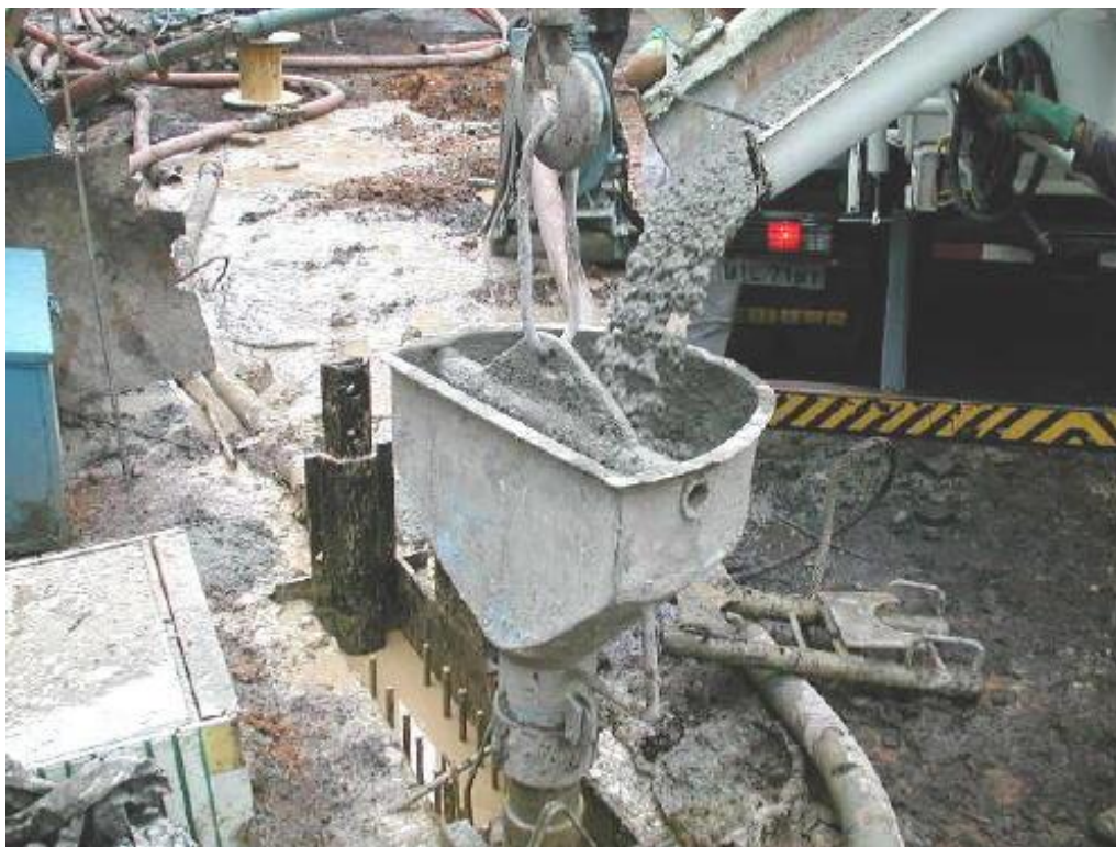
Figura 5 - Concretagem com “tremie”
