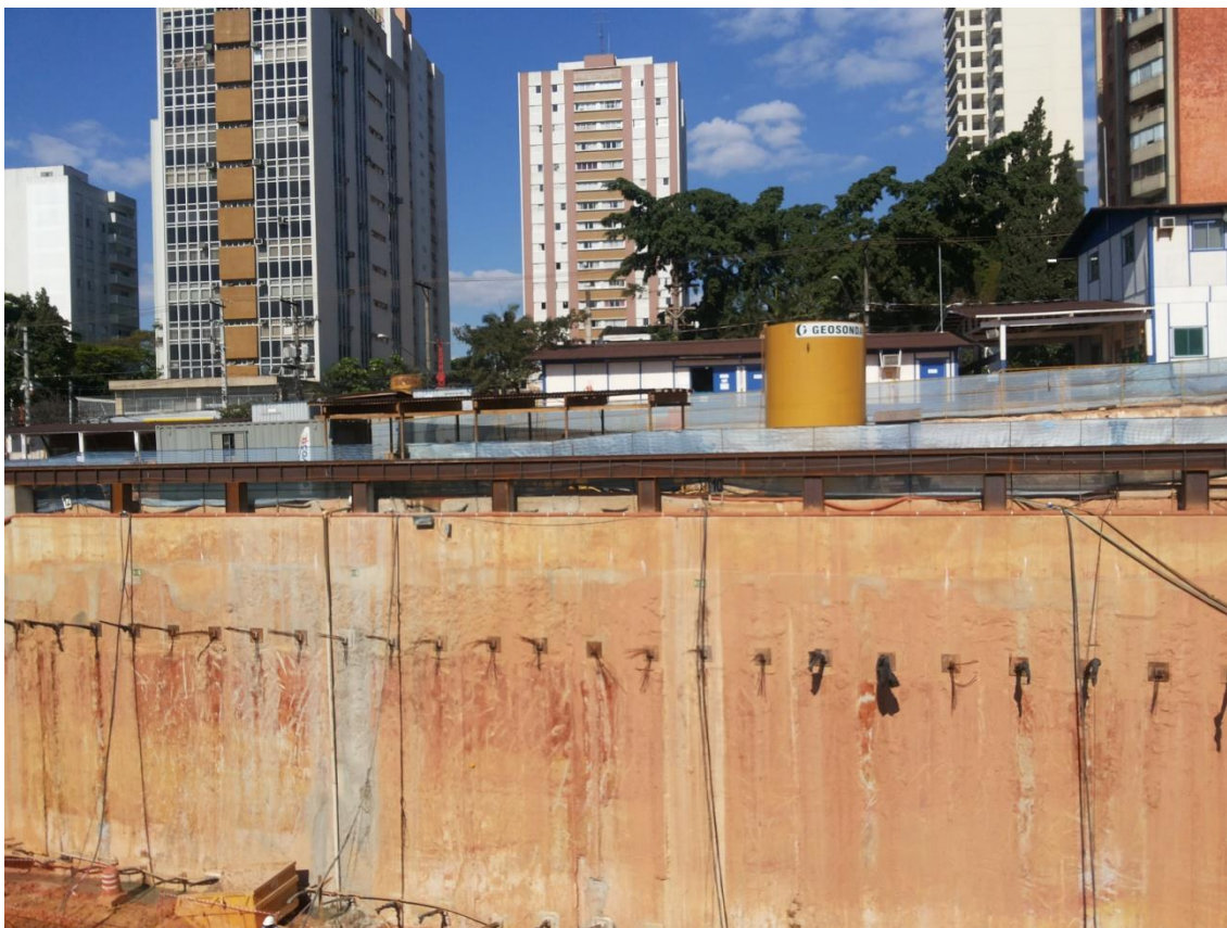
Figura 37 - primeiro e segundo nível de execução de tirantes, estação 2
