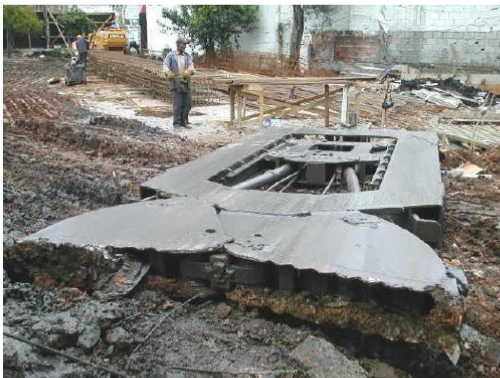
Figura 25 - detalhe do Clamshell Hidráulico
