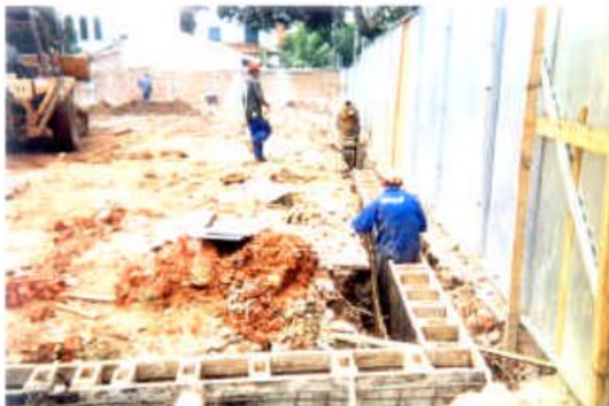
Figura 23 - Fôrma da mureta guia
