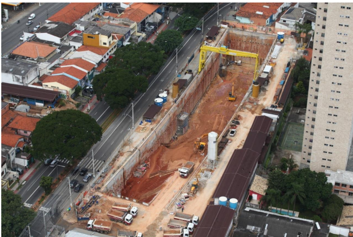
Figura 33 - Imagem aérea da estação 1 na etapa de escavação
