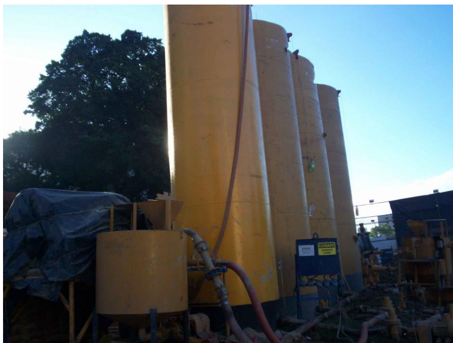
Figura 12 - Silos de armazenamento
