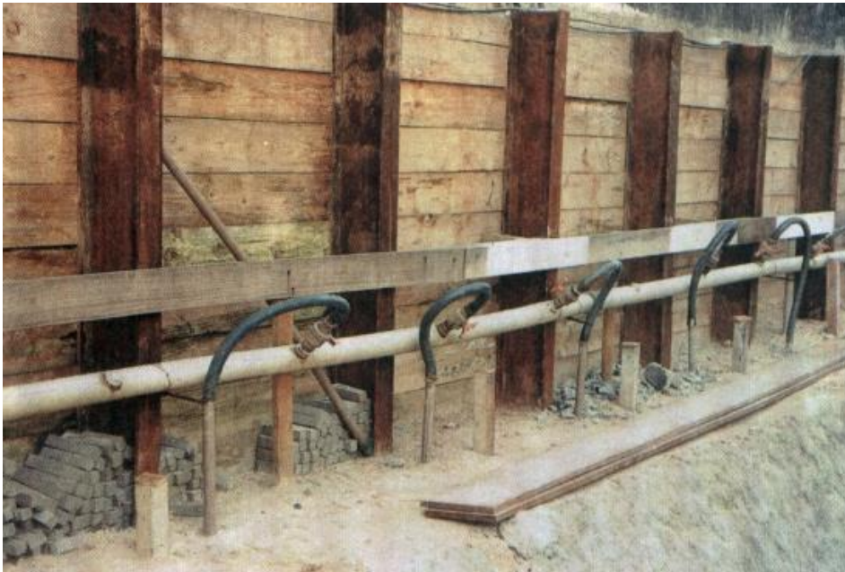
Figura 15 - Esquema do perfil de uma ponteira filtrante operacional.
