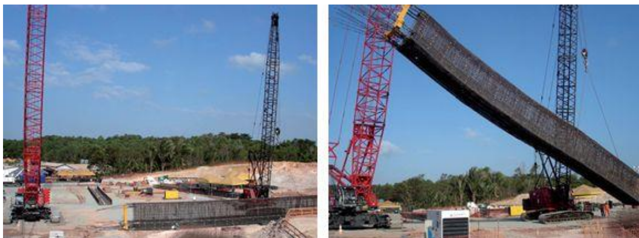
Figura 30 - Içamento da gaiola de uma parede diafragma com 2 guindastes
