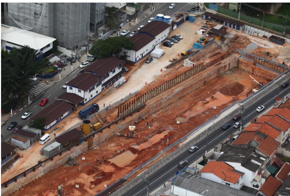
Figura 35 - Imagem aérea da estação 2 na etapa de escavação
