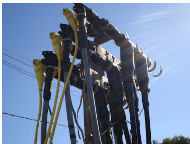
Figura 2.6 Rede de distribuição aérea Loadbreak Cemig
