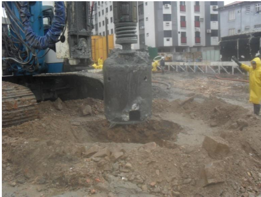
Figura 6 – Posicionamento para realização do pé furo, a fim de fixar a camisa guia
