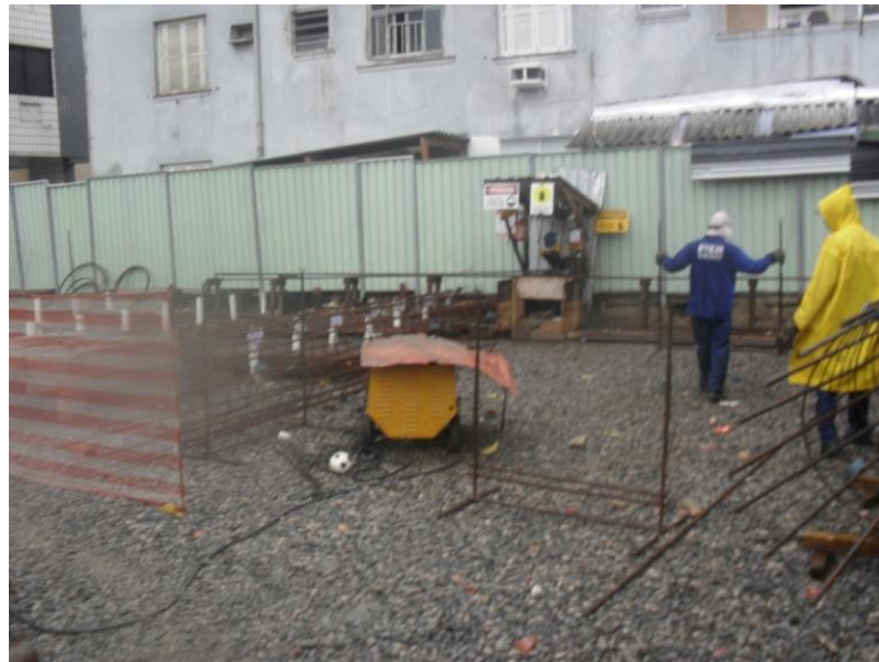
Figura 7 – Local de confecção da armadura da estaca
