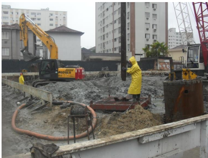
Figura 11 – Início da montagem do tubo tremonha
