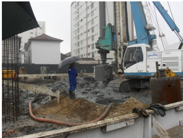
Figura 5 – Perfuratriz esvaziando a caçamba com material escavado
