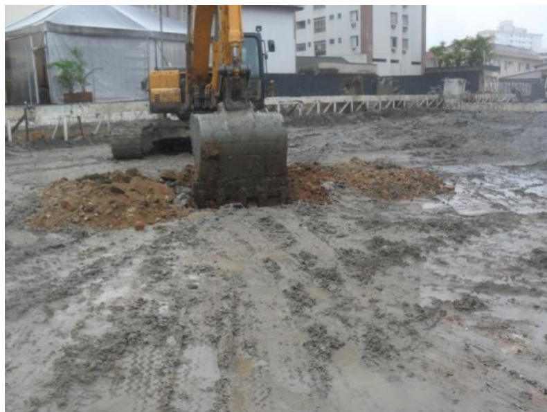
Figura 2 – Abaixamento da cota de locação com o auxílio da escavadeira
