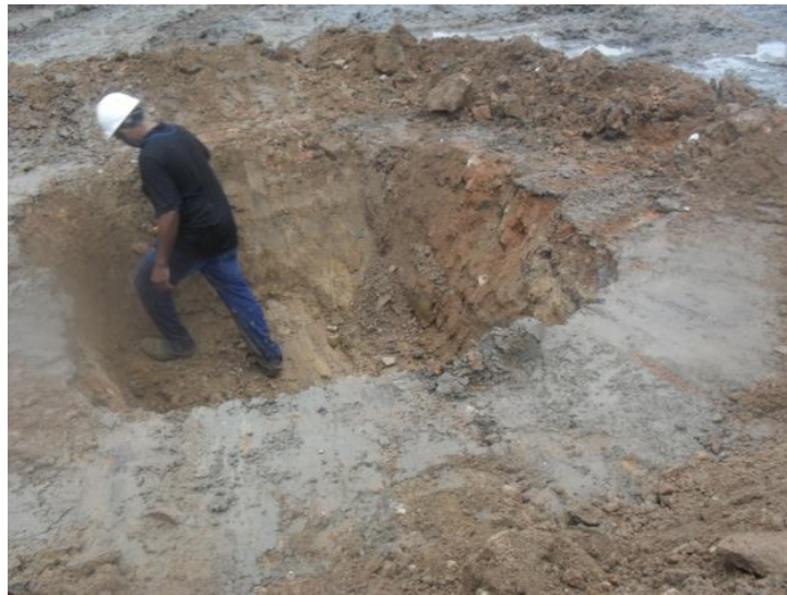
Figura 3 – Relocação da estaca na nova cota, utilizando-se de prumo e gabarito
