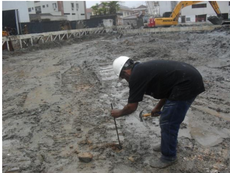
Figura 1– Locação da estaca
