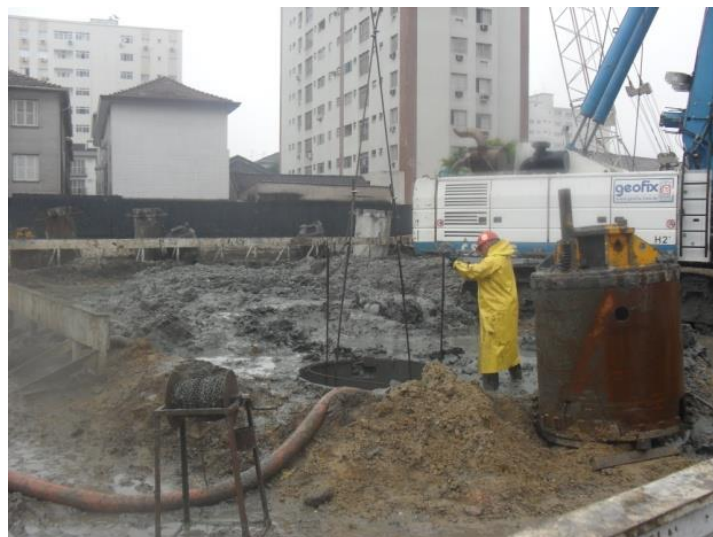
Figura 4 – A camisa gui auxilia na descida e travamento da ferragem
