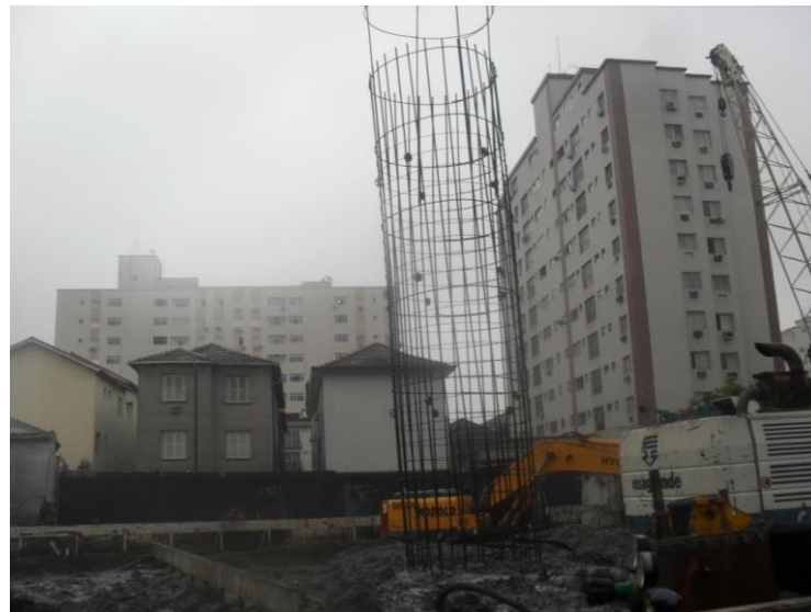
Figura 8 – Levantamento da armadura para inserção no furo, antes da concretagem
