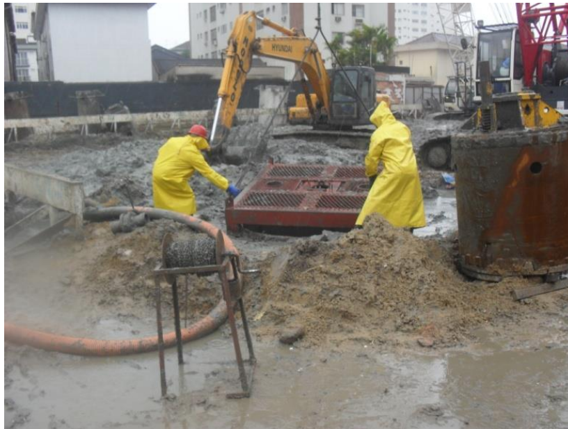
Figura 10 – Instalação da plataforma de concretagem
