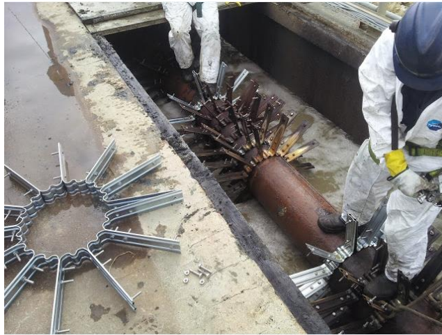
Figura 13 - Conjunto de palhetas da ETE.
