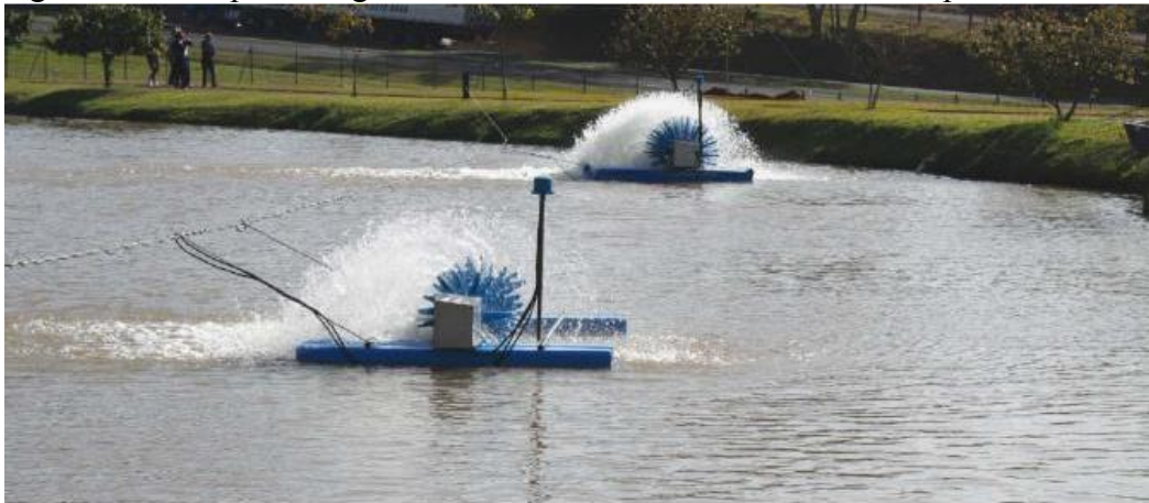
Figura 1 - Exemplo de lagoa aerada mecanicamente com aerador tipo cachoeira.
