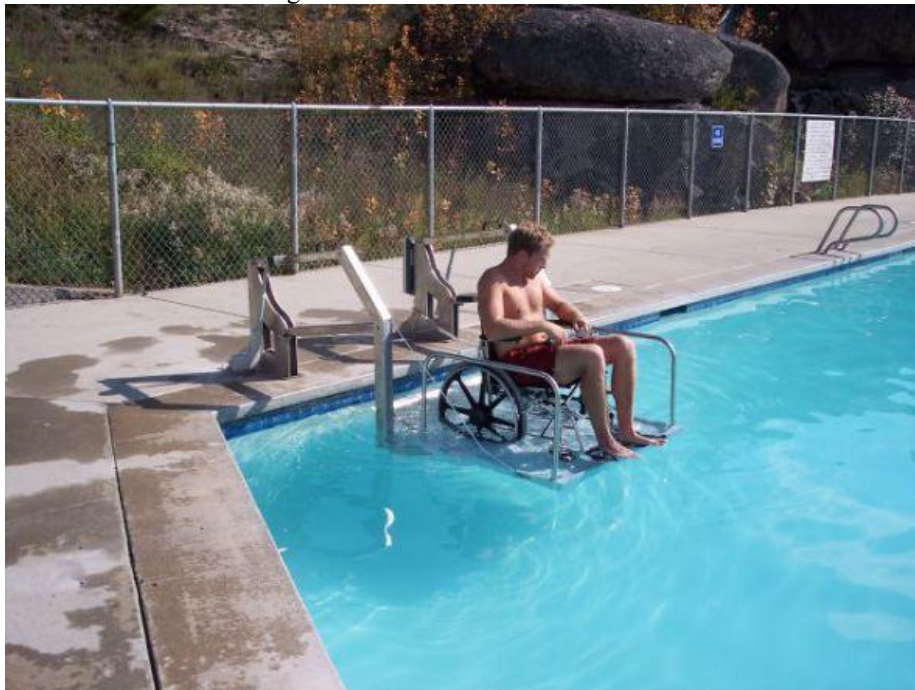
Figura 3 - Elevador de acessibilidade
