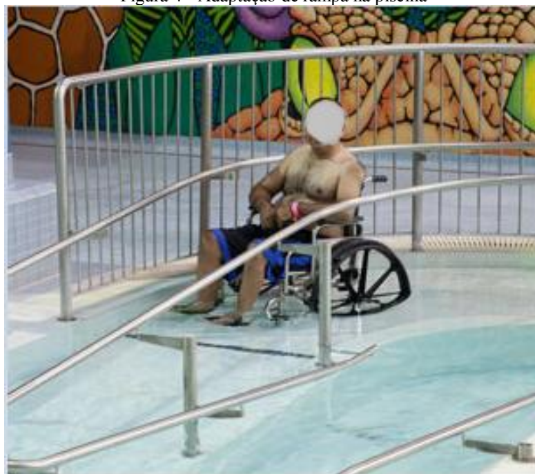
Figura 4 - Adaptação de rampa na piscina
