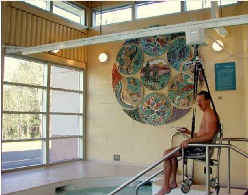
Figura 2 - Elevador com motor elétrico
