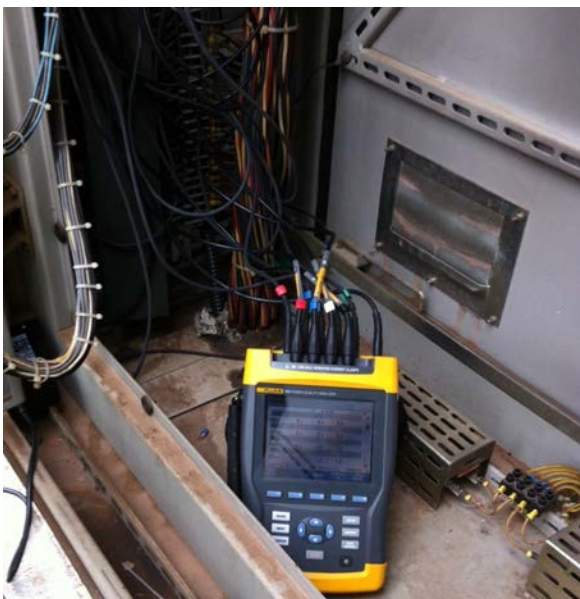
Figura 13 – Instalação medidor no painel subestação 1
