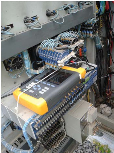
Figura 30 – Instalação medidor no painel subestação 3
