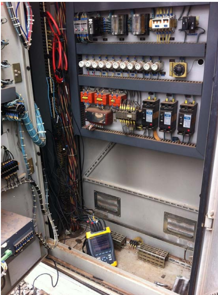
Figura 12 – Visão geral instalação da medição no painel subestação
