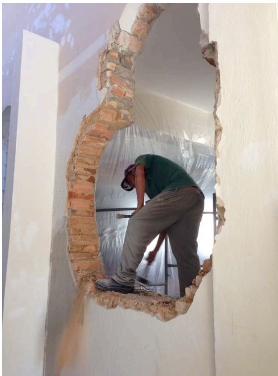
Figura 21 - Trabalhador usando técnica manual para desfazer parte de uma parede.
