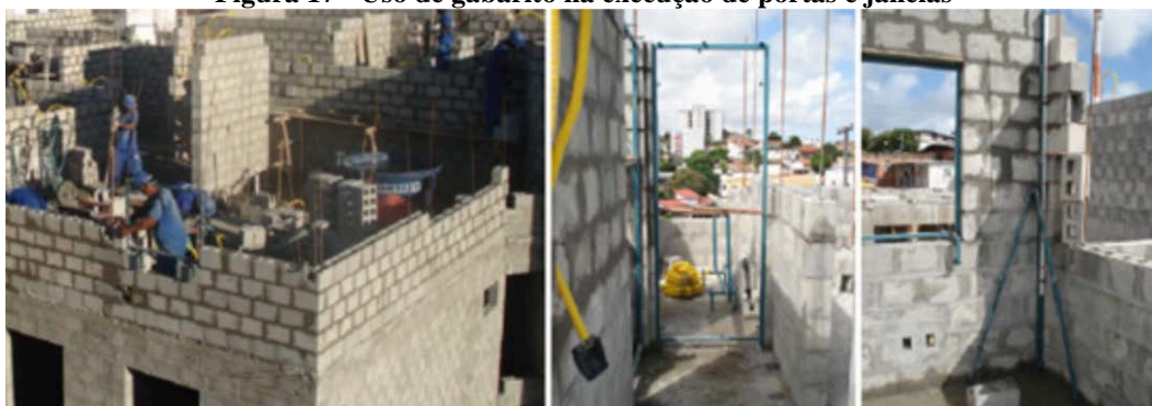
Figura 17 - Uso de gabarito na execução de portas e janelas
