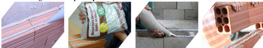
Figura 15 - Etapas do processo de assentamento de blocos com cola blocos
