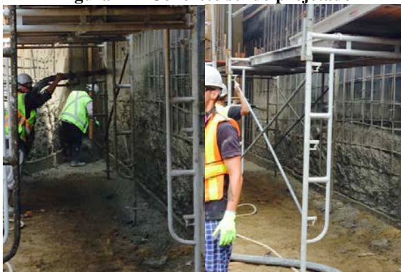
Figura 14 - Concreto sendo projetado
