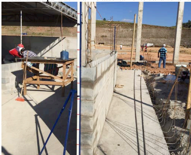
Figura 16 - Escantilhão para auxiliar no assentamento da alvenaria estrutural.
