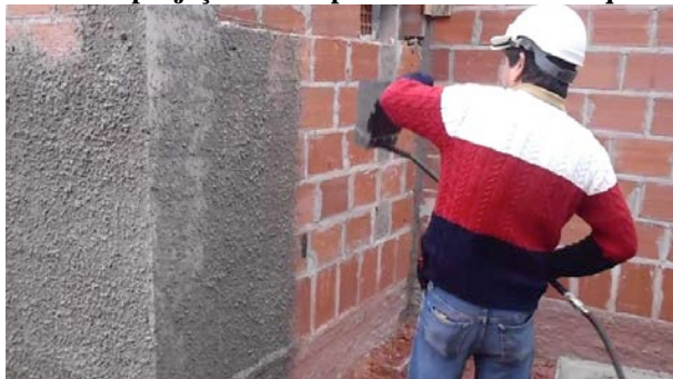
Figura 18 - Técnica de projeção de chapisco utilizando a máquina chapiscadora
