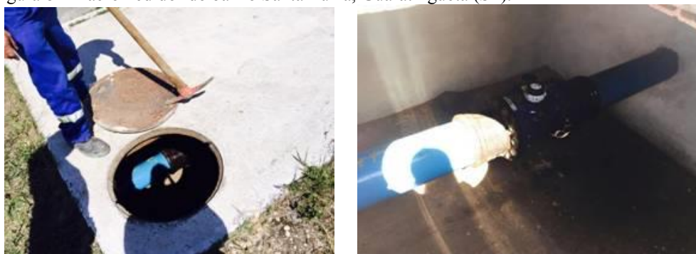
Figura 8 - Macromedidor do bairro Santa Luzia, Guaratinguetá (SP).
