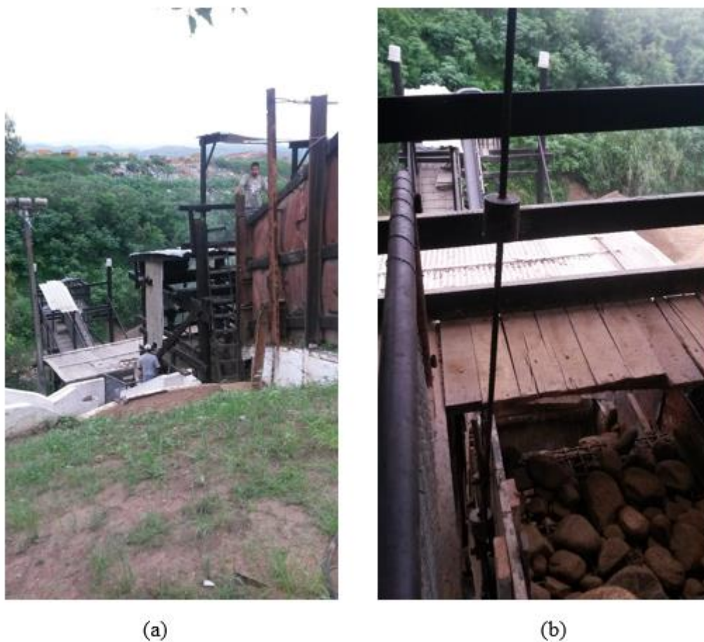
Figura 4 - Britagem: (a) estrutura utilizada para o processamento do cascalho; (b) cascalho sendo direcionado para o processamento.
