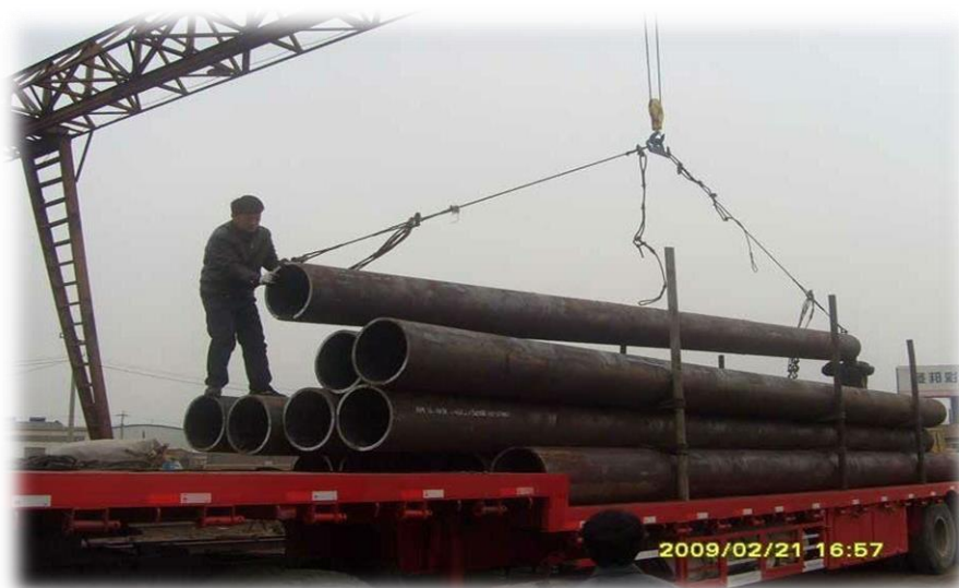
Figura 2: Dutos empilhados prontos para a conexão ou soldagem.
