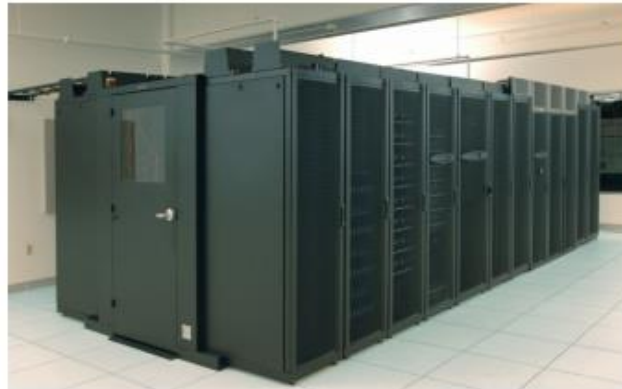
Figura 2.14 Solução de confinamento de corredor quente
