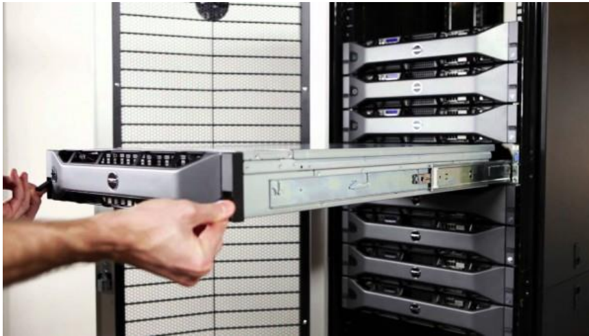
Figura 2.3 Servidores alocados dentro do rack
