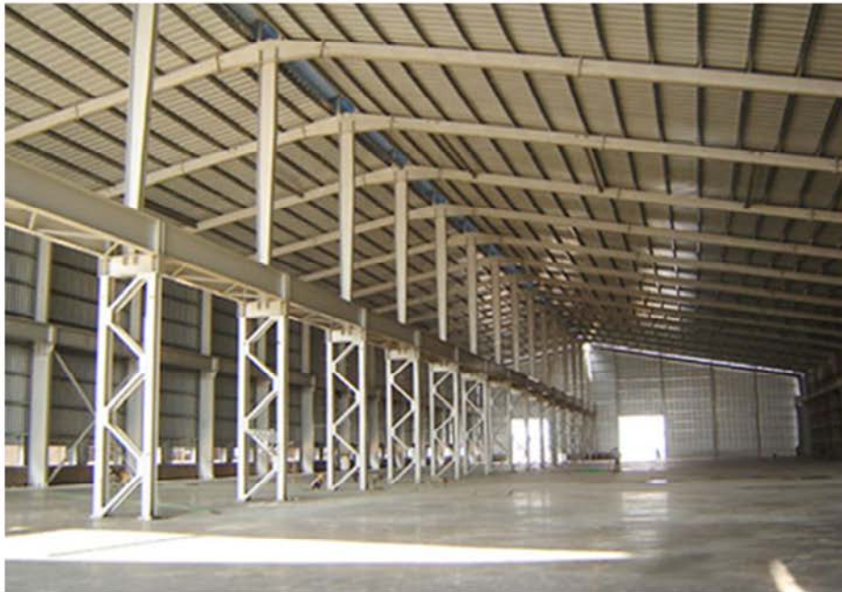
Figura 1 – Estrutura em aço com pilares metálicos compostos.
