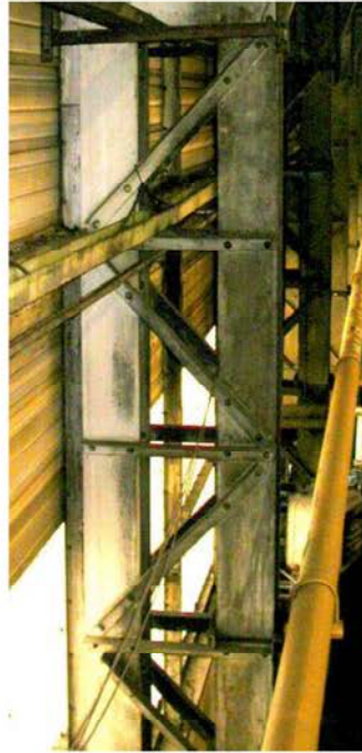
Figura 7 – Vedação de um edifício industrial suportada por pilares compostos.
