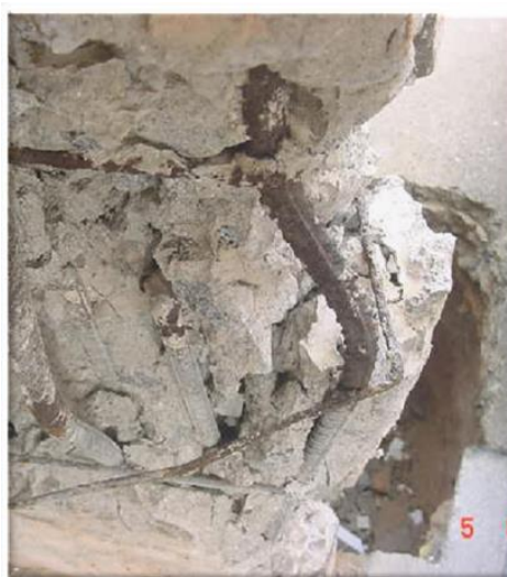
Figura 1: Detalhe mostrando a flambagem da barra longitudinal entre os estribos.
