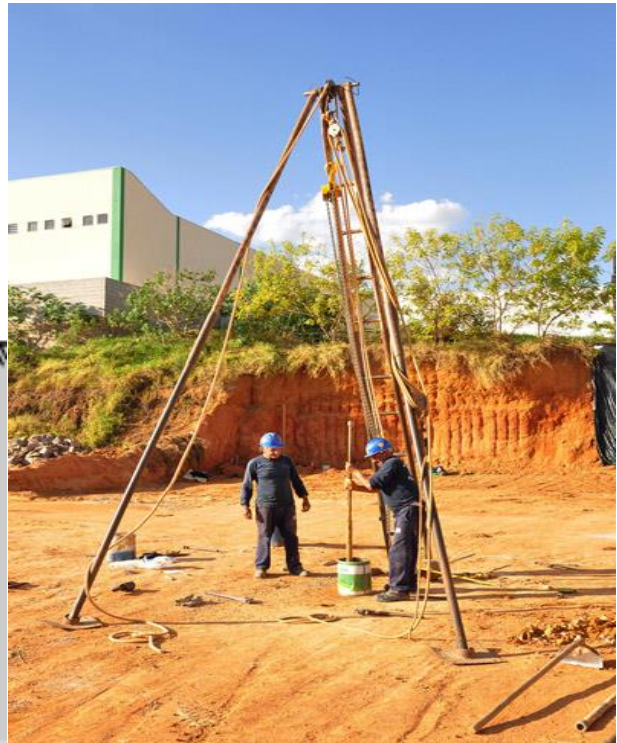
Figura 11.2 - Execução do SPT
