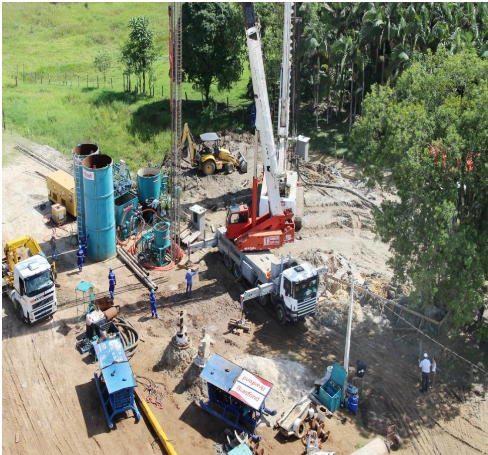
Figura 29 - Vista aérea do processo executivo da estaca ET4
