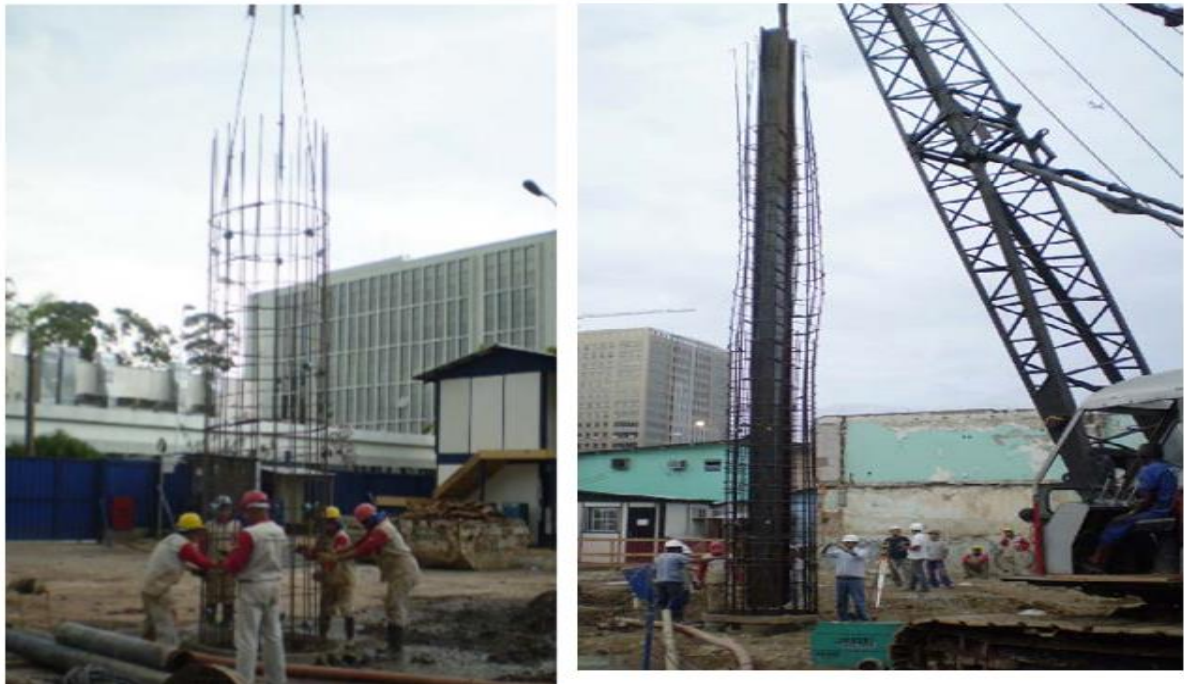
Figura 18 e 18.1 - Colocação da armadura da estaca
