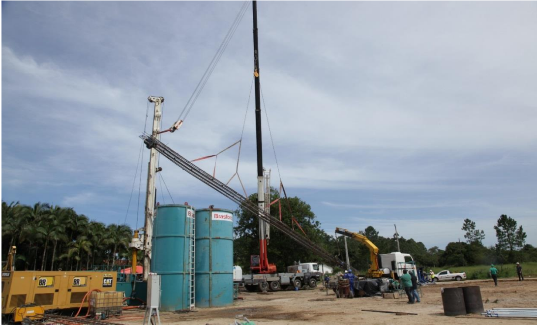
Figura 29.3 – Armadura da estaca Et4 sendo colocada.
