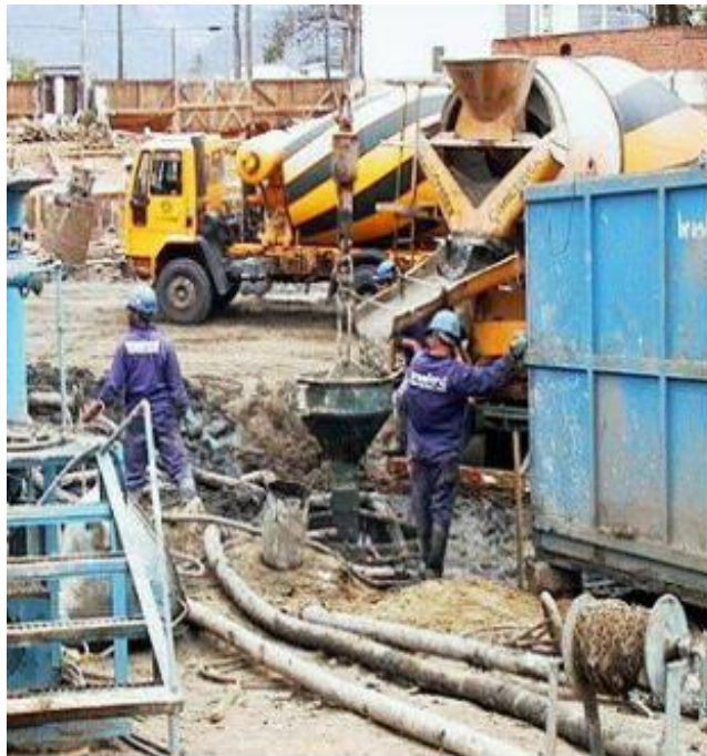
Figura 19 - Lançamento do concreto na tremonha
