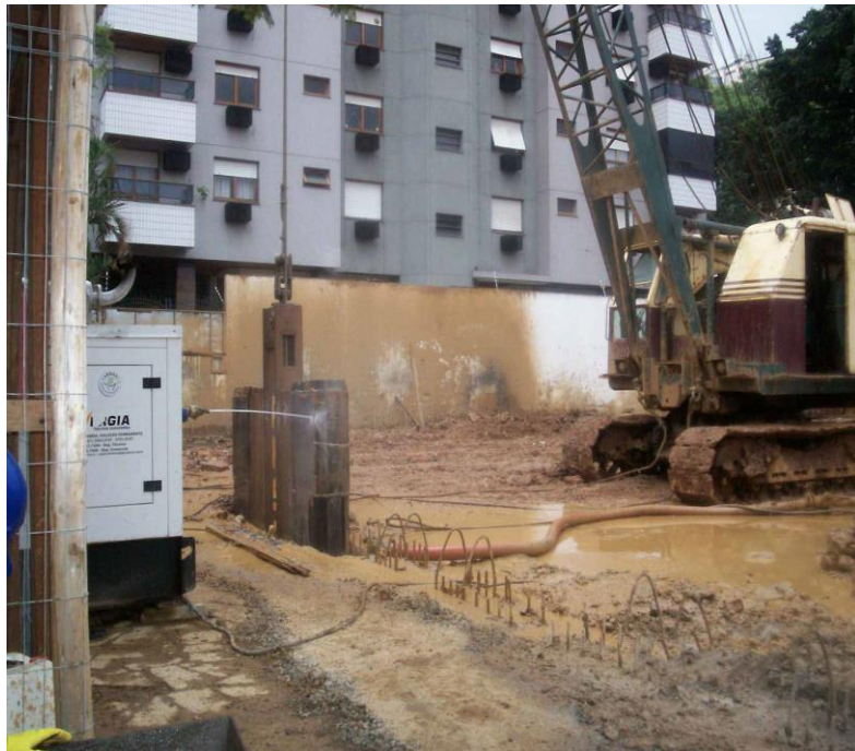
Figura 17 - Colocação do tubo guia
