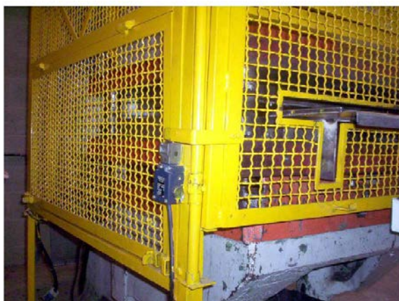
Figura 56 – Enclausuramento da zona de prensagem por proteções móveis intertravadas
