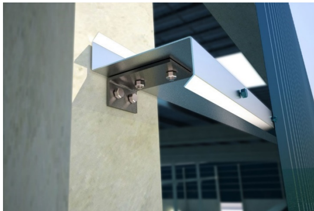
Figura 5 – Exemplos de tipo de fixação por meio de parafusos.
