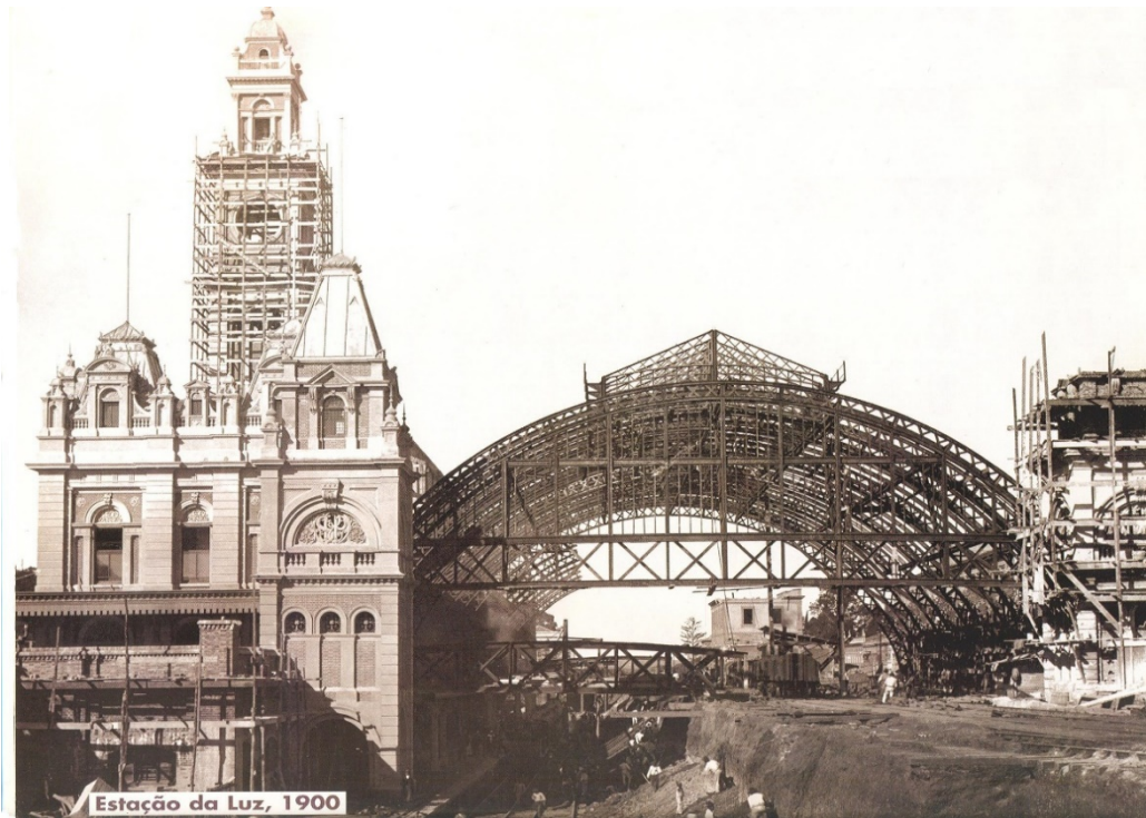
Figura 1 - Estação da Luz em construção, São Paulo
