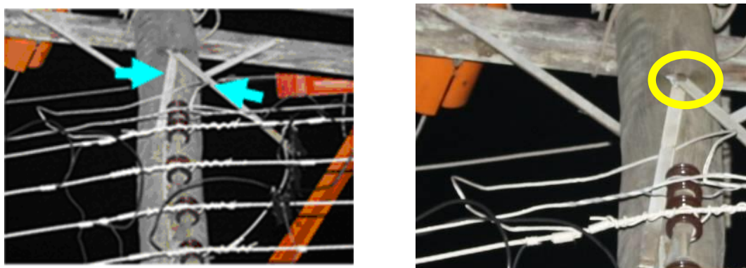
Figura 25: Mão francesa encostando-se a linha energizada.
