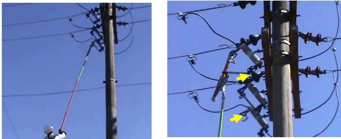
Figura 15: Sequência de atividade para a abertura das chaves corta circuito.
