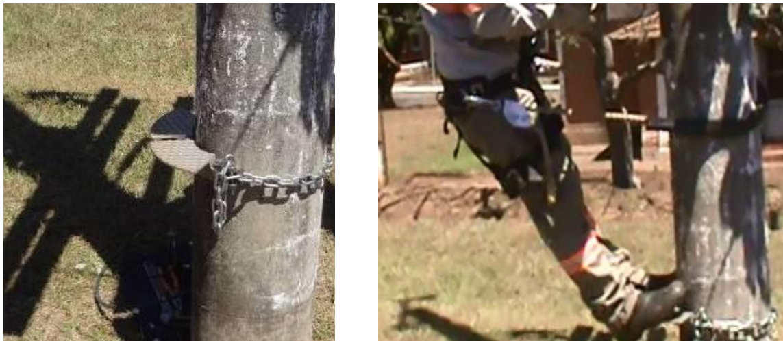
Figura 18: Plataforma que é utilizada pelos eletricitistas para execução de atividade em altura no poste.
