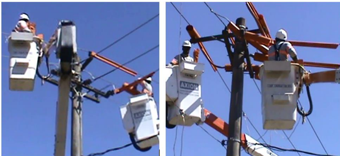
Figura 22: Imagem de simulação da cobertura da linha viva através de invólucros de cor laranja.
