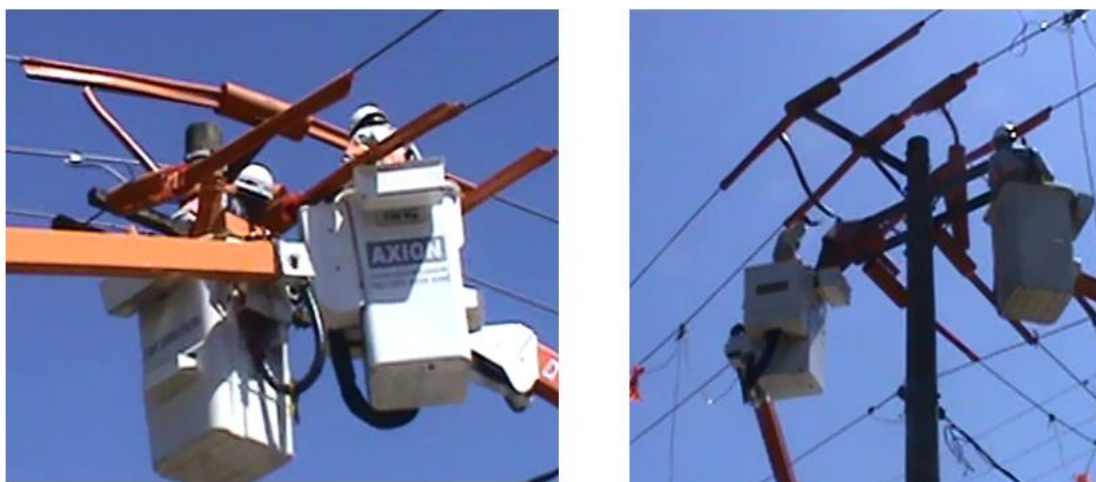
Figura 23: Imagem da atividade de retirada da cruzeta em linha viva.
