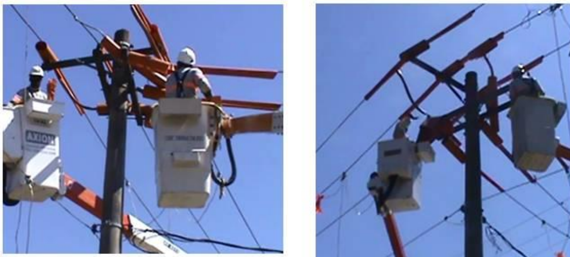
Figura 11: Tarefa de colocação de equipamento de proteção coletiva em linhas energizadas e após finalização início da retirada da cruzeta com a linha energizada.
