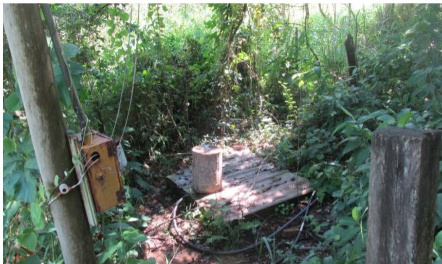
Figura 9 - Poço de captação da água da nascente 11. Fonte: Juan Pieroni (2015).
