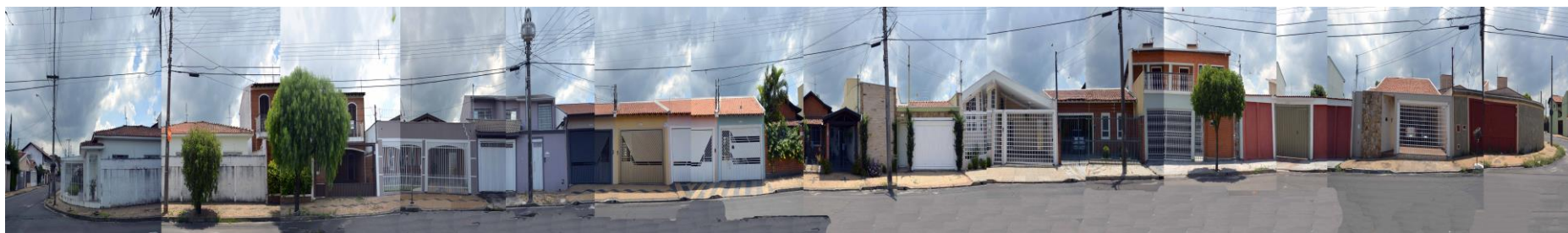
Foto 5 – Panorâmica localização quadra E, lateral 2
