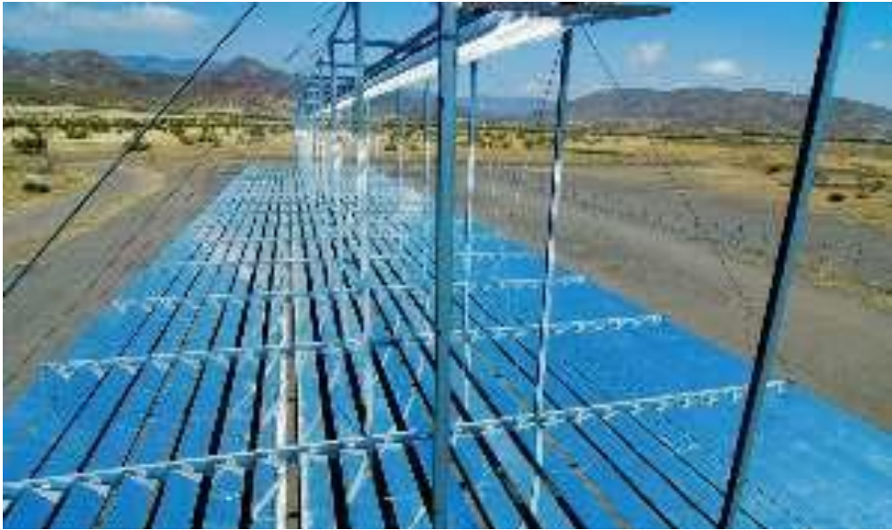
Figura 14 – Concentrador de foco linear de espelhos facetados
