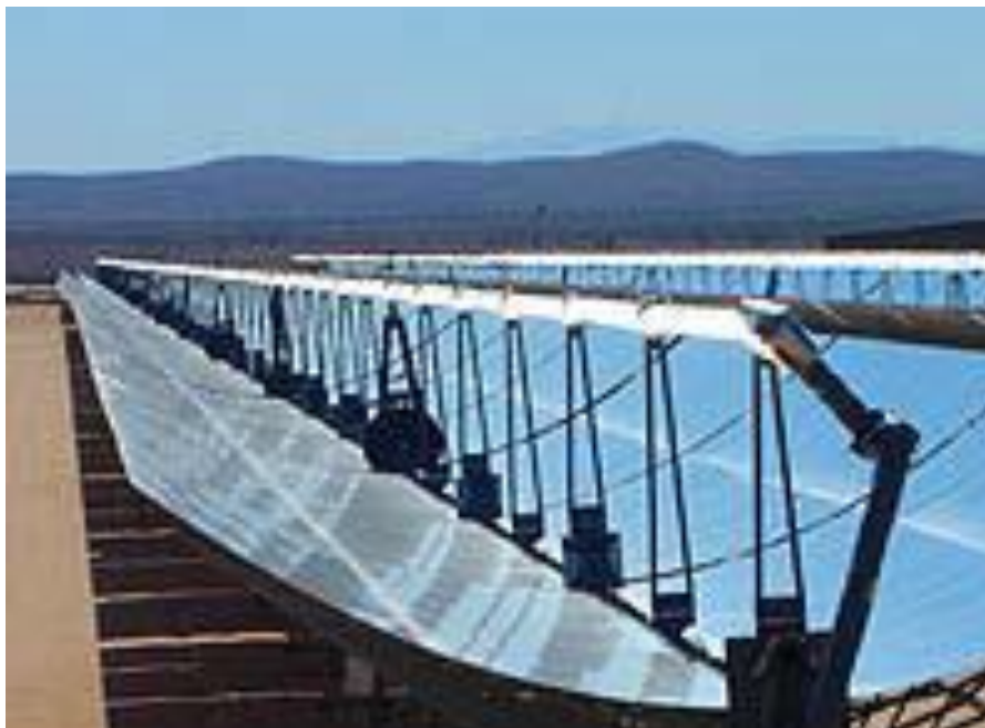
Figura 13 - Concentrador de foco linear semicilíndrico parabólico
